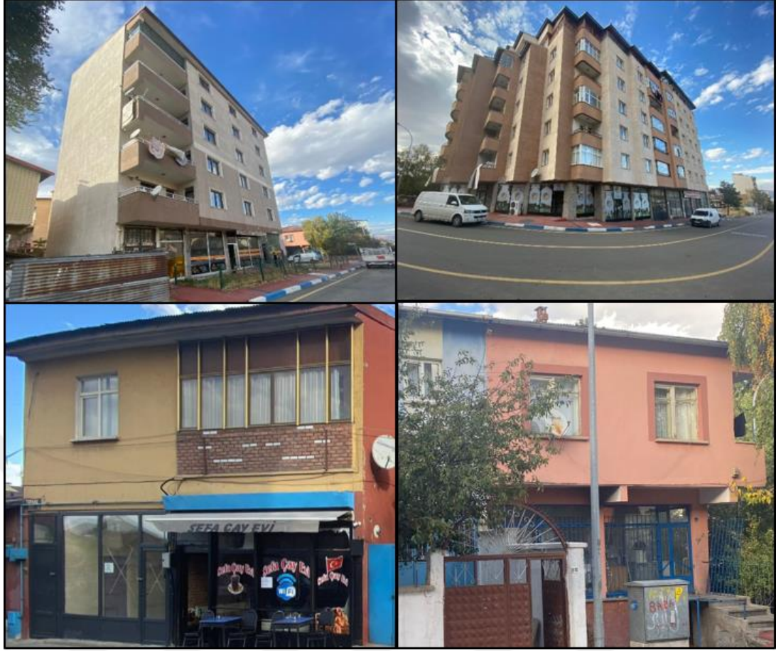
Şekil 4.31. Çalışma alanında yumuşak kat/zayıf kat düzensizliğine sahip bazı bina görselleri.
