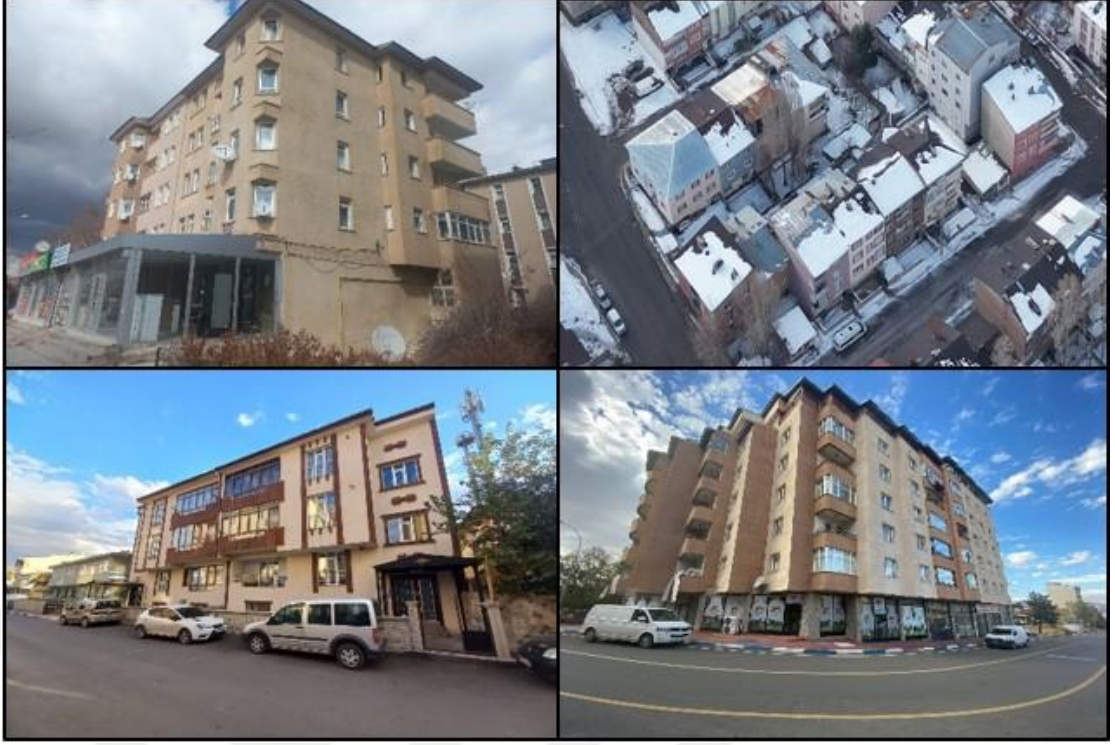
Şekil 4.22. Çalışma alanlarındaki bazı binaların sokaktan görünümüleri
