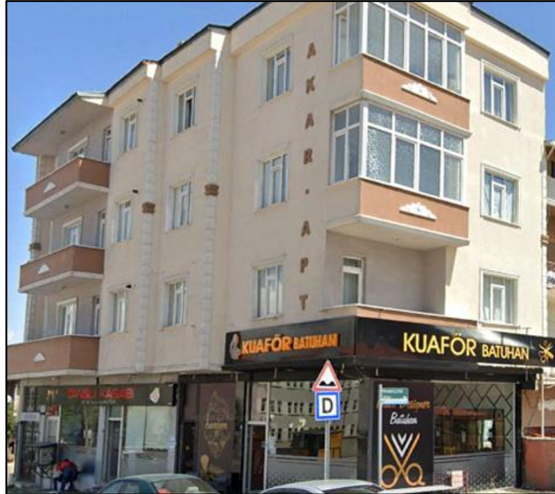
Şekil 5.2. Mimari projesi girintili yapı örneği
