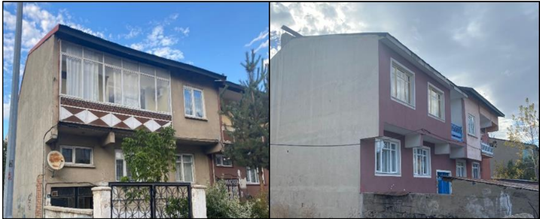
Şekil 4.32. Çalışma alanında ağır çıkma düzensizliğine sahip bazı bina görselleri
