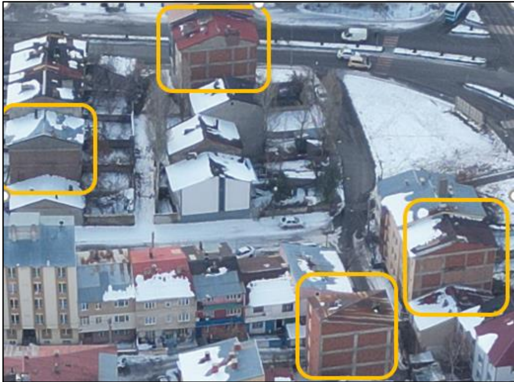
Şekil 4.29. Projesi olmayan ve taşıyıcı sistemi sahada tespit edilen binalar
