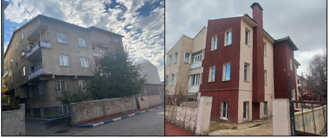
Şekil 4.30. Çalışma alanında bodrum kat durumu farklı bazı bina görselleri
