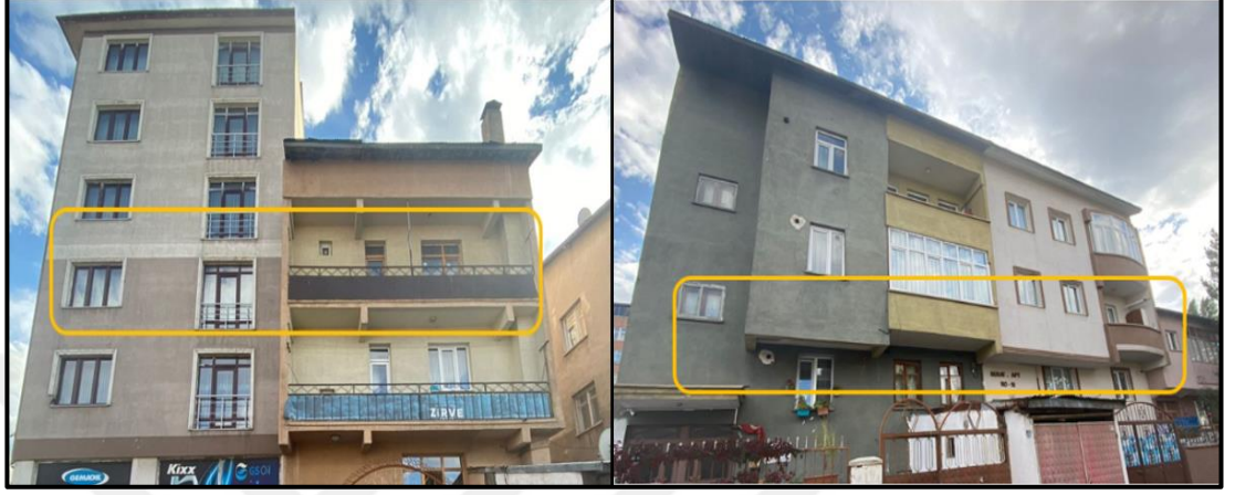
Şekil 4.33. Çalışma alanında döşeme seviye durumu farklı bazı bina görselleri
