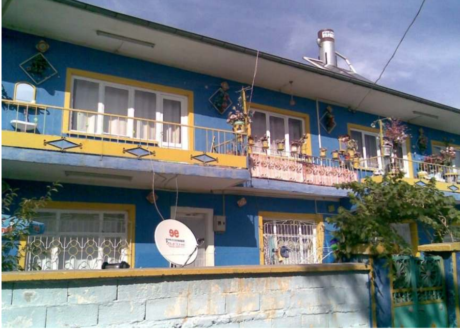
Şekil 2.15 Yığma yapılan ve dış görünüşü kaliteli yapı
