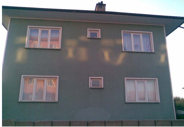
Şekil 2.20 Duvar boşluğu düzenli bir yığma bina
