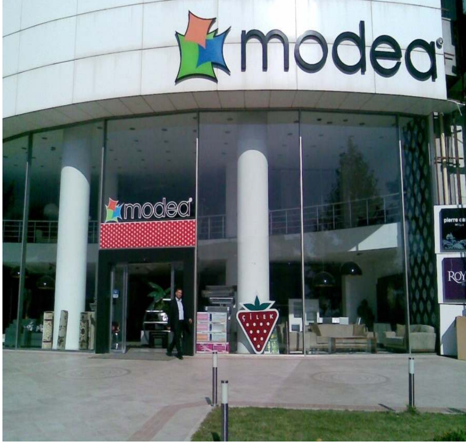
Şekil 2.6 Yumuşak katlı bir betonarme bina
