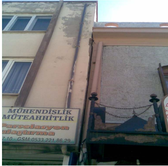
Şekil 2.14. Birbirine bitişik ve çarpışma etkisi oluşturan yapılar
