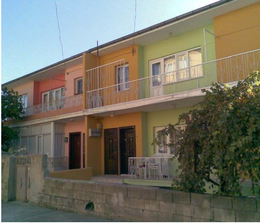
Şekil 2.17 Duvar boşluk oranı fazla olan bina
