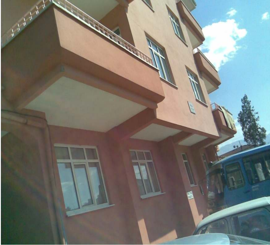
Şekil 2.9. Ağır çıkmalı yapılmış bina
