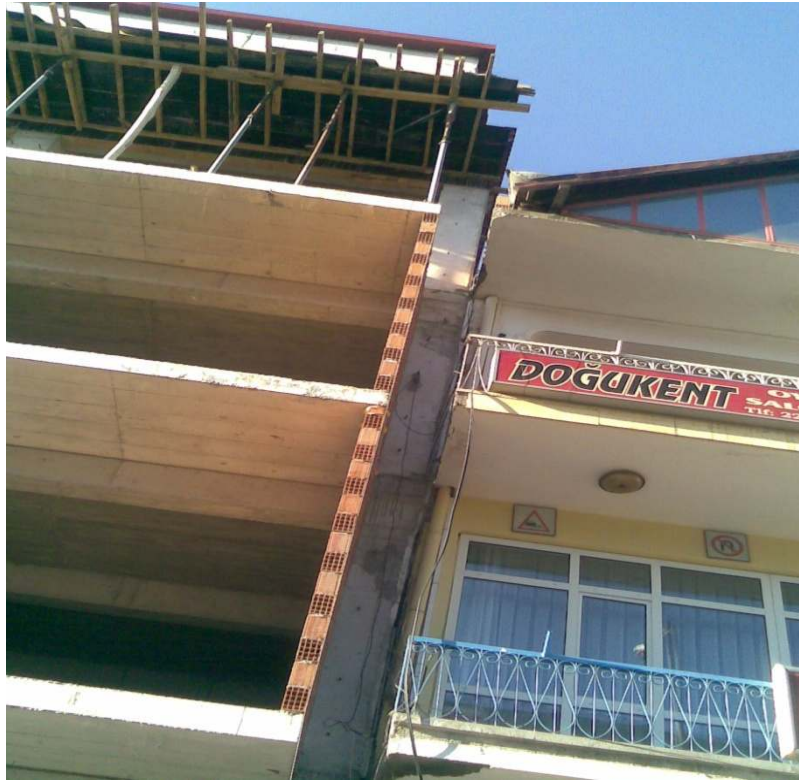
řekil 2.12. arpıřma etkisi olan binalar
