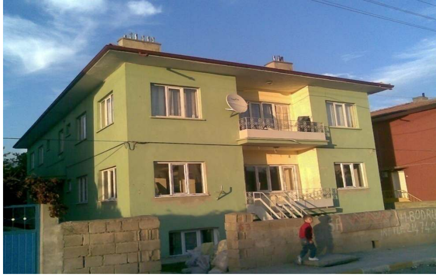
Şekil 2.21 Duvar boşluk düzeni, düzenli bir yığma bina
