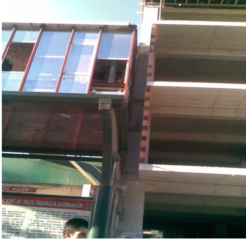
Şekil 2.13. Çarpışma etkisi olan binalar
