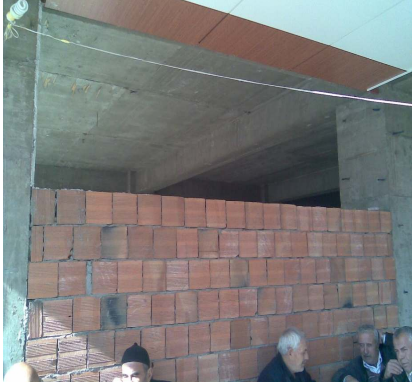
Şekil 2.10. Kısa kolon oluşumuna sebep olan duvar.
