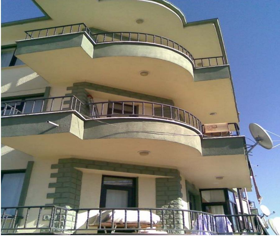
Şekil 2.8. Geniş, ağır parapetli bir balkona sahip bina
