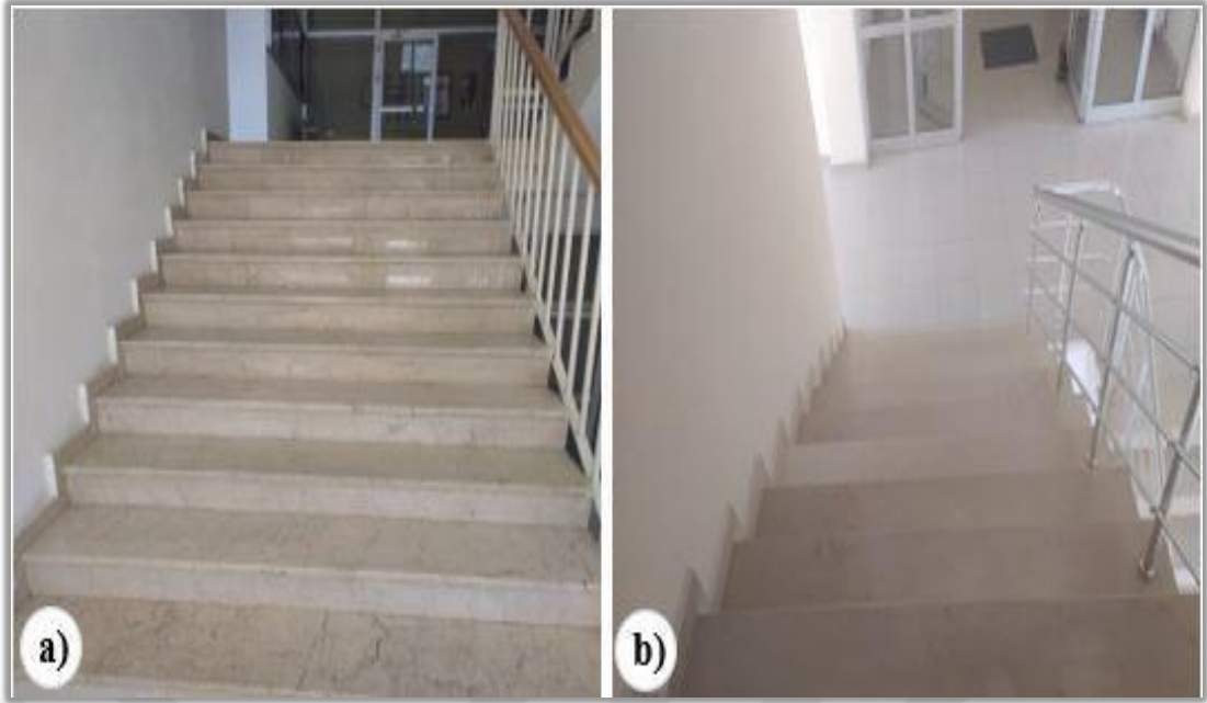
Şekil 19. Mühendislik ve Doğa Bilimleri Fakültesi kaçış merdivenleri a) 1. kat kaçış merdiveni b) 2. kat kaçış merdiveni
