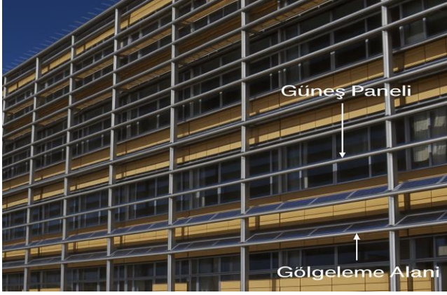
Şekil 2.8. Cephede Pv uygulaması (Reijenga ve Architecten 2001)
