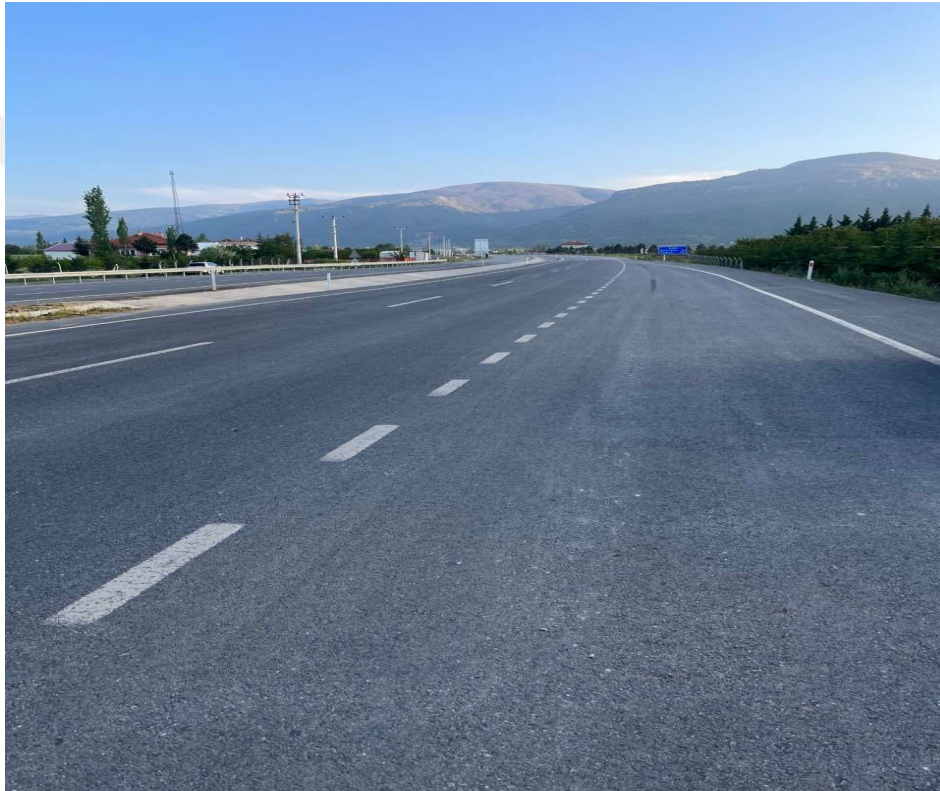
Şekil 4.6 Test çalışmaları yapılan hız kesici set bulunmayan yol profili.
