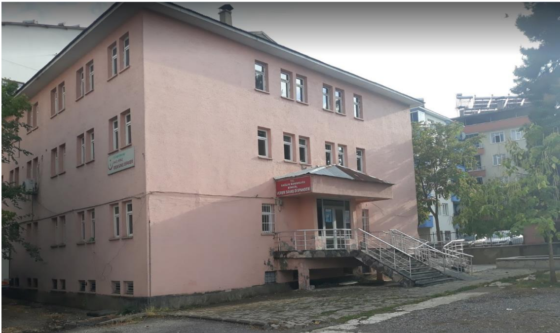
Şekil 2 2: Verem Savaş Dispanseri hizmet binası
