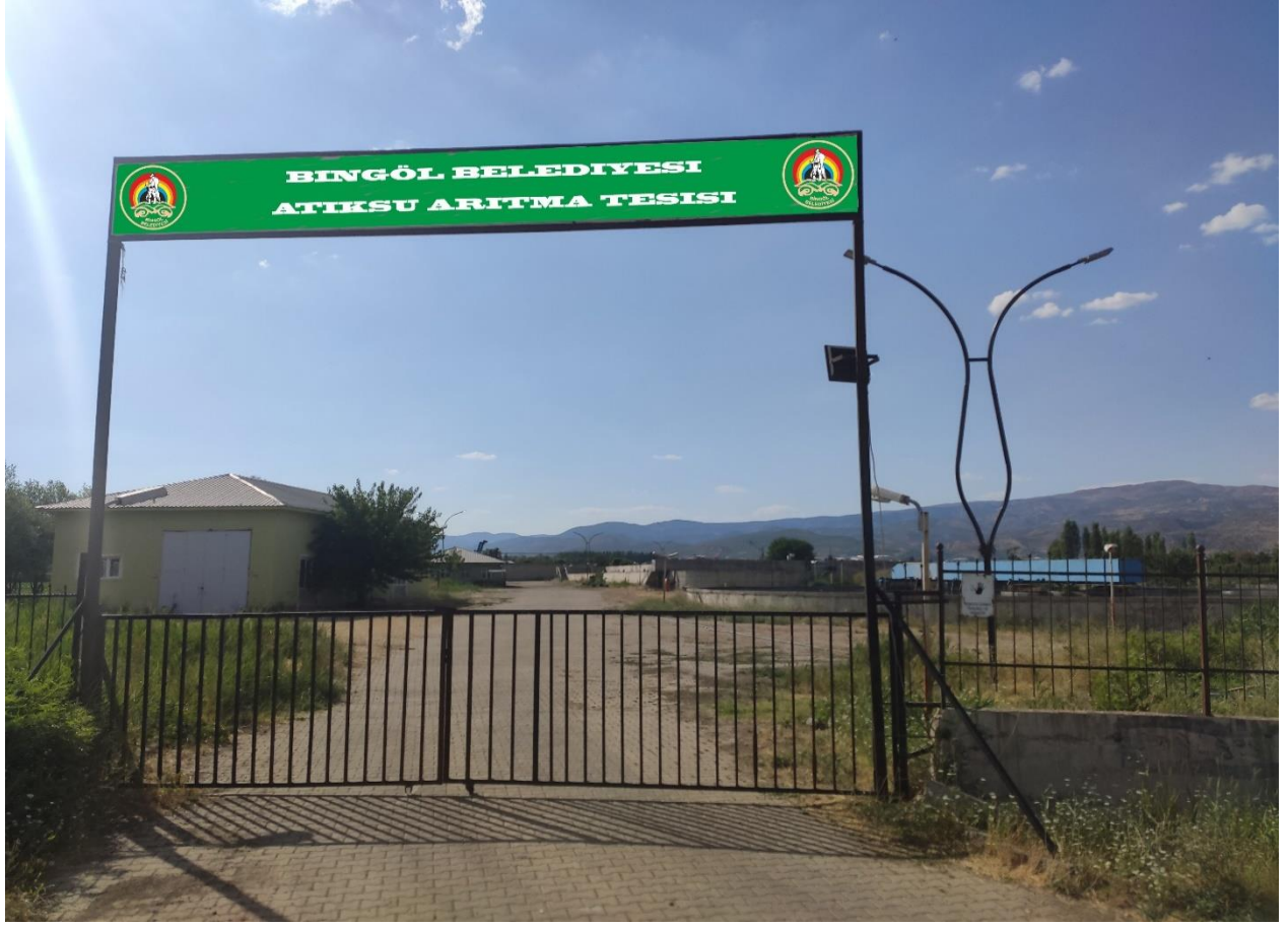
Şekil 3.2. Bingöl Belediyesi Atıksu Arıtma Tesisi
