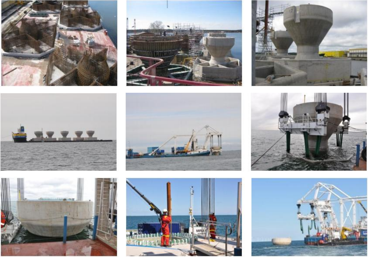
Şekil 2.10: Gravite temel sistemli açık deniz rüzgar türbininin üretimi, montaj alanına transferi ve kurulum aşamaları (E.ON 2011).
