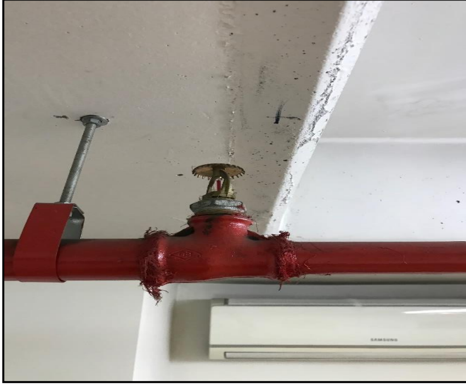
Resim 4.21. Yukarı yönlü sulu yangın söndürme başlığı
