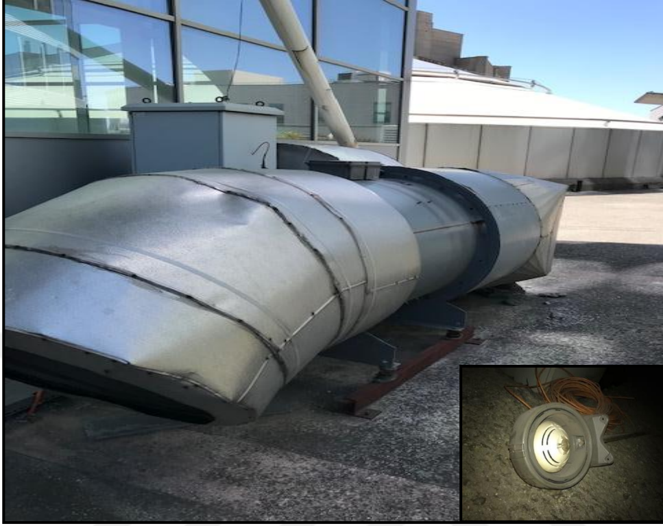
Resim 4.4. Duman tahliye fan motoru ve duman algılama detektörü
