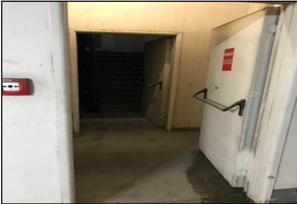
Resim 4.2. Yangın kaçış kapısı, yangın güvenlik holü ve açıl kaçış merdiveni
