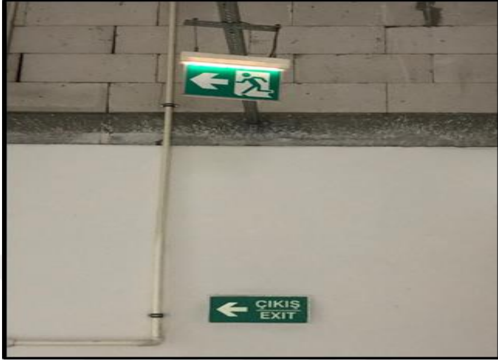
Resim 4.14. Işıklı ve Fosforlu acil kaçış yönlendirmesi
