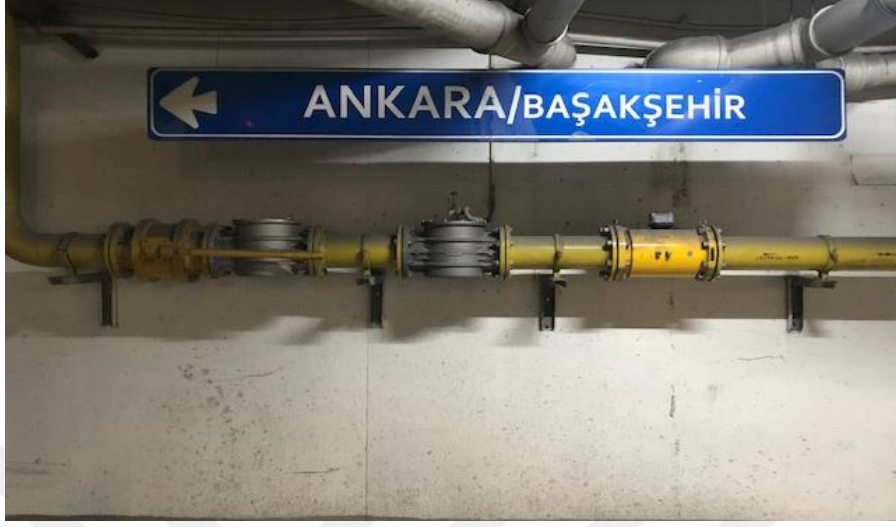
Resim 4.16. Selenoid gaz kesme vanası
