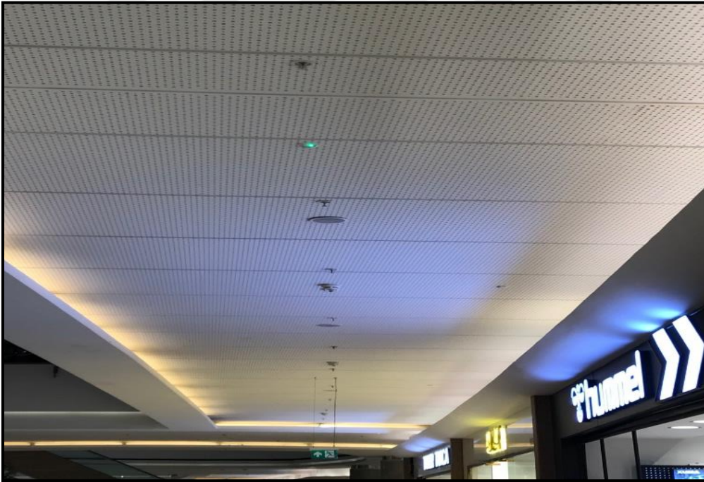
Resim 4.20. Aşağı tip sulu yangın söndürme sistemi örneği
