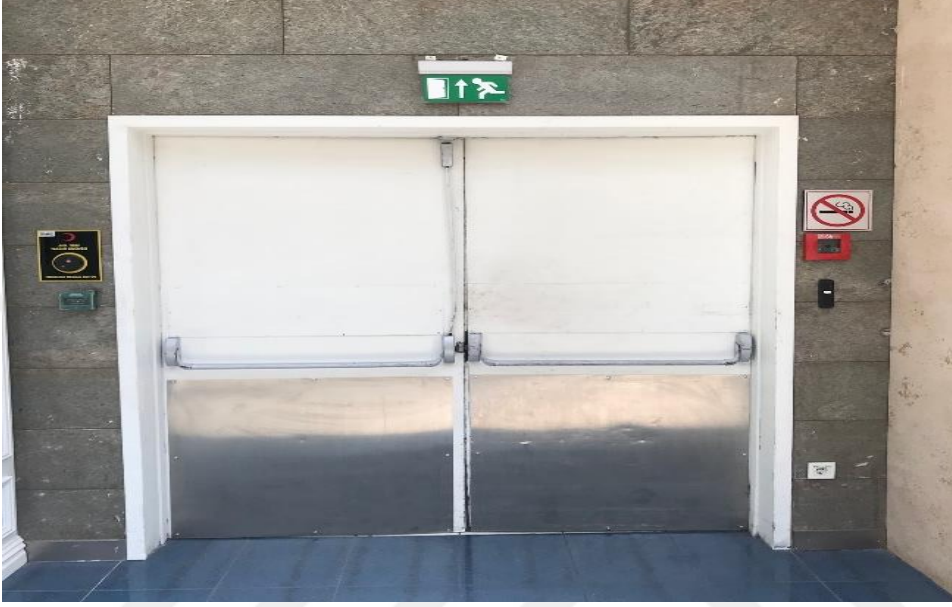
Resim 4.17. Push-bar kapı ve elektromanyetik tutuculu kilit sistemi
