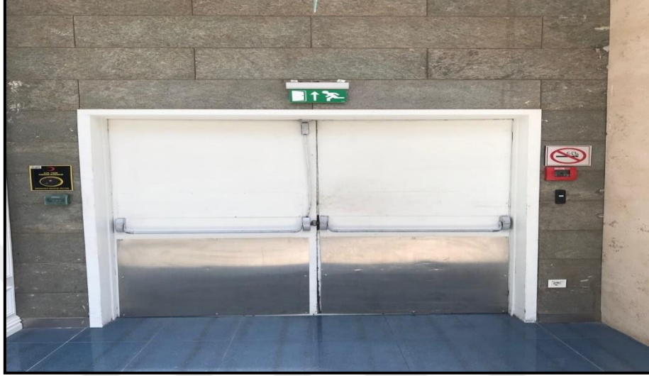
Resim 4.1. 90 dakika dayanımlı yangın kaçış kapısı
