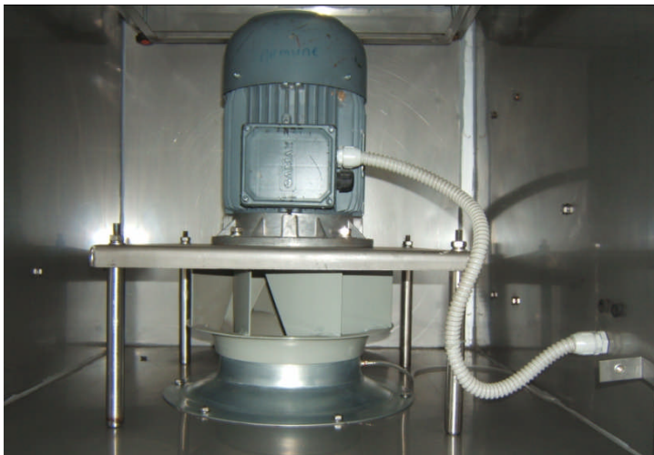
Resim 7.3. Elektrik motorunun fanla bağlantısı [6]
