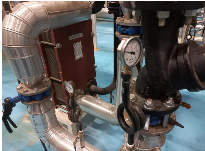
Şekil 6.69. LT sekonder devresi sirkülasyon pompası giriş ve çıkış basınç değerleri
