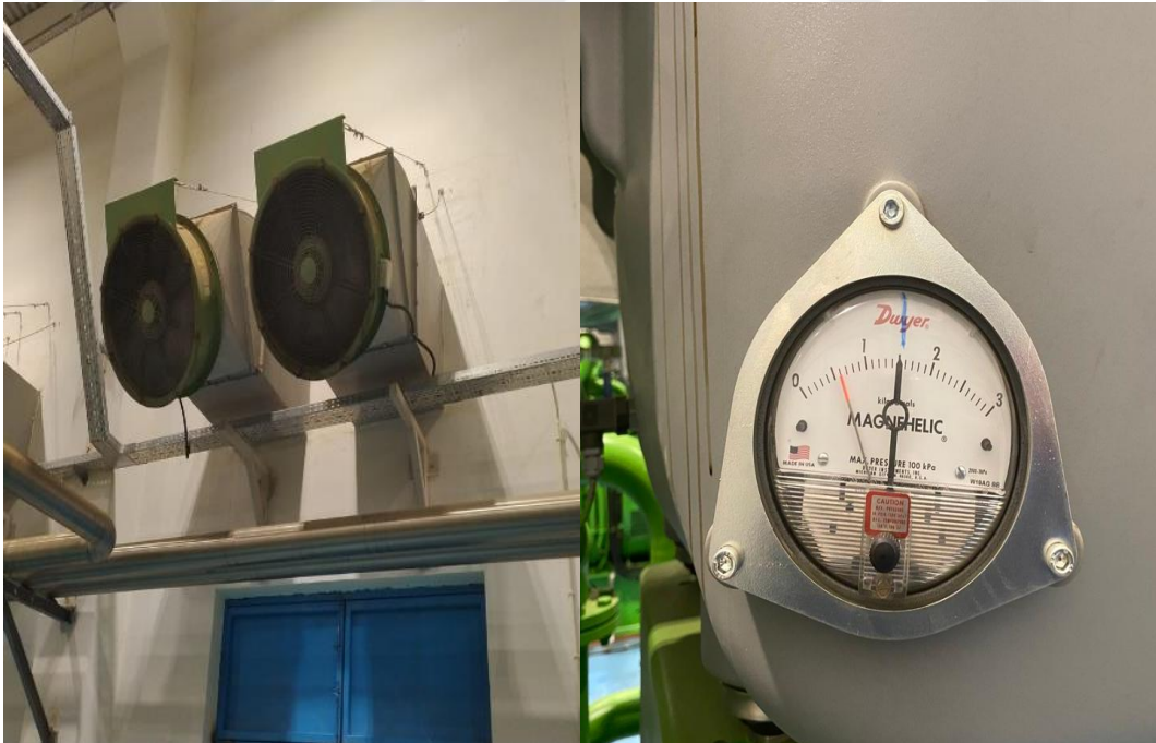
Şekil 6.42. Taze hava fanları ve kaset filtre basınç göstergesi
