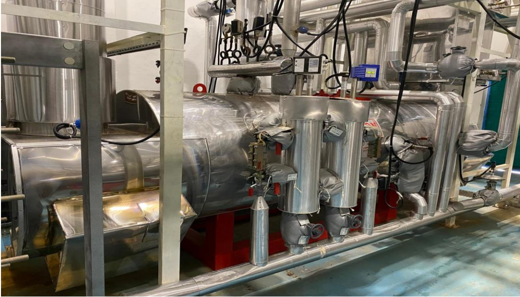
Şekil 6.11. Atık ısı kazanı
