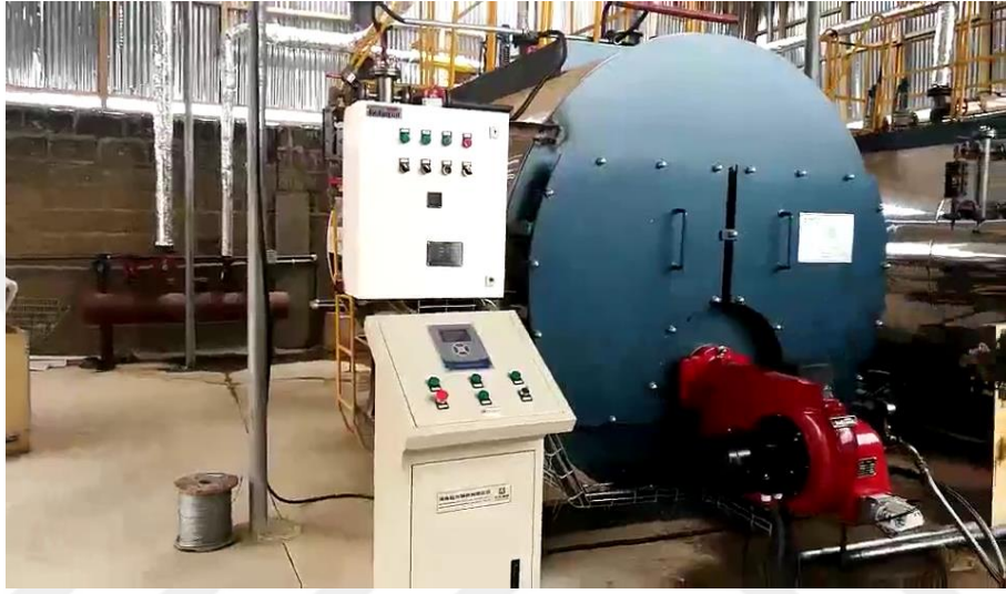
Şekil 4.4. Biyogaz yakıtlı brülör
