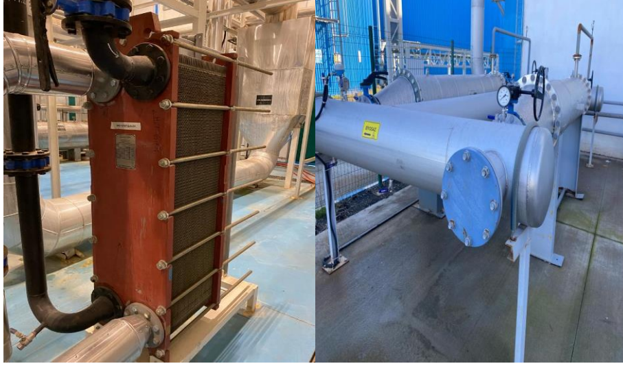
Şekil 6.9. Plakalı ve borulu ısı değıştirciler
