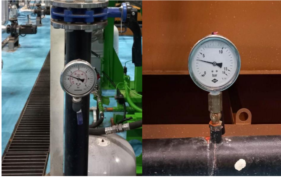
Şekil 6.62. HT sirkülasyon pompası öncesi ve sonrası basınç değerleri
