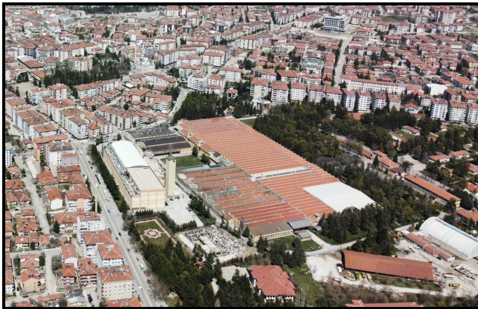
Şekil 4.1. Sümerbank Fabrikasının Kent Merkezine Gömülmüş Haldeki Görüntüsü (Yazar Arşivi 2022)
