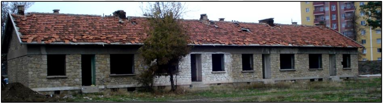
Şekil 5.65. Sümerbank Ereğli Fabrikası, İşçi Konutları-Taş Evler, 3.TİP C Blok Giriş Cephesi
