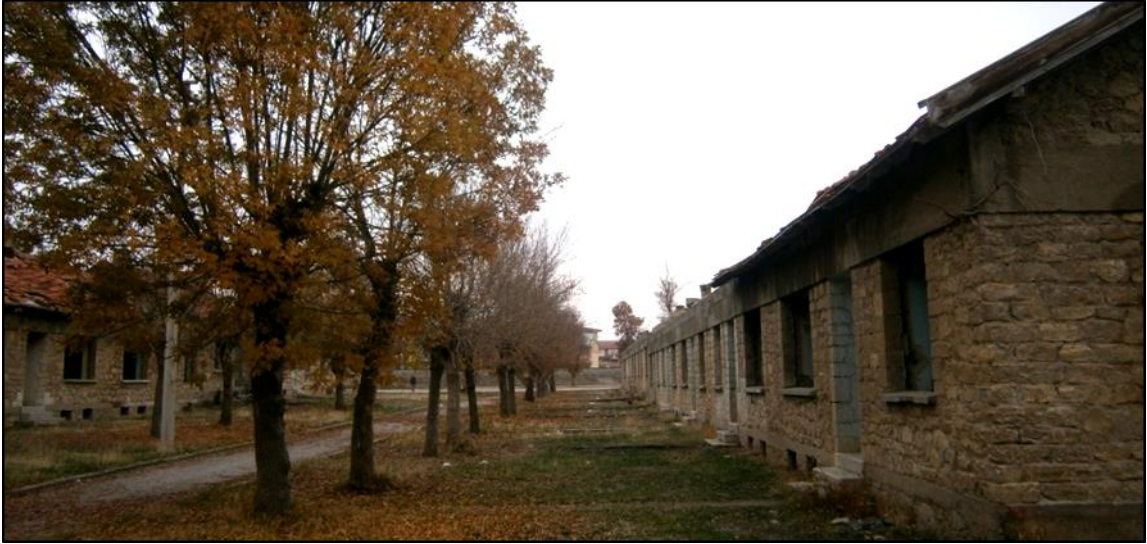
Şekil 5.64. Sümerbank Ereğli Fabrikası, İşçi Konutları-Taş Evler, 3.TİP A ve B Blokların Karşılıklı Bakan Giriş Cepheleri
