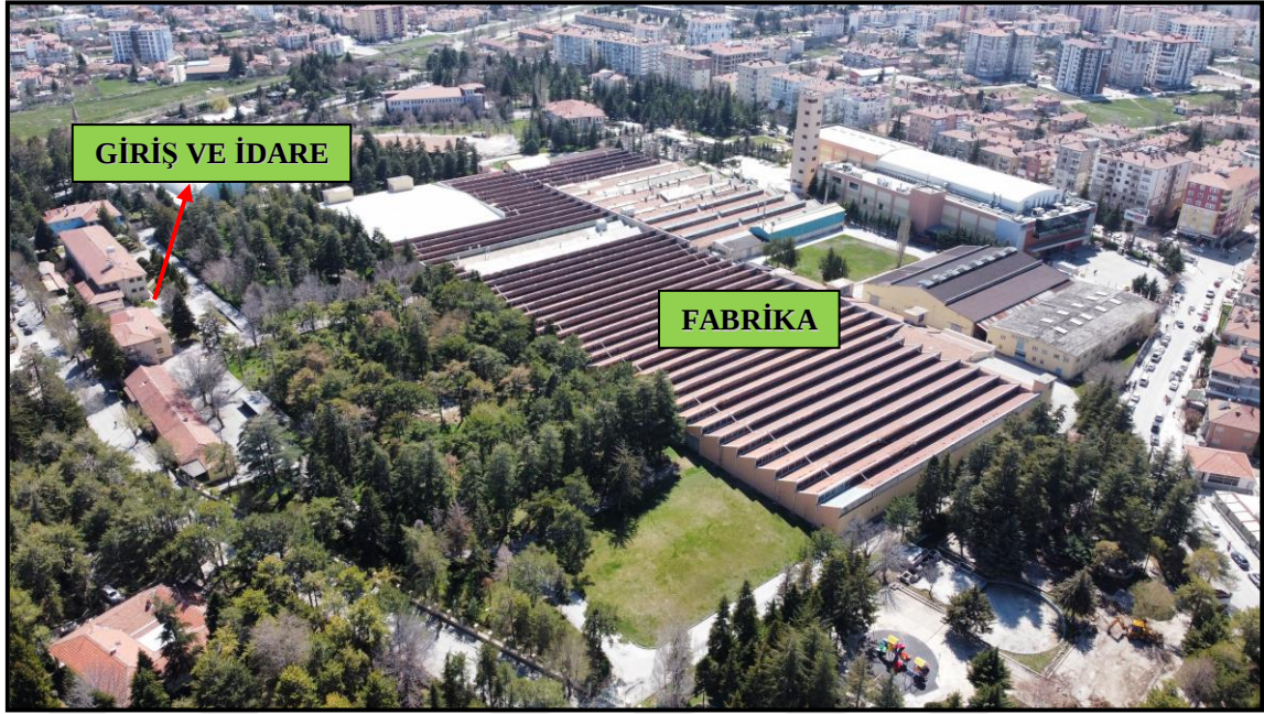
Şekil 5.30. Sümerbank Fabrika Sahası (Yazar Arşivi, 2022)
