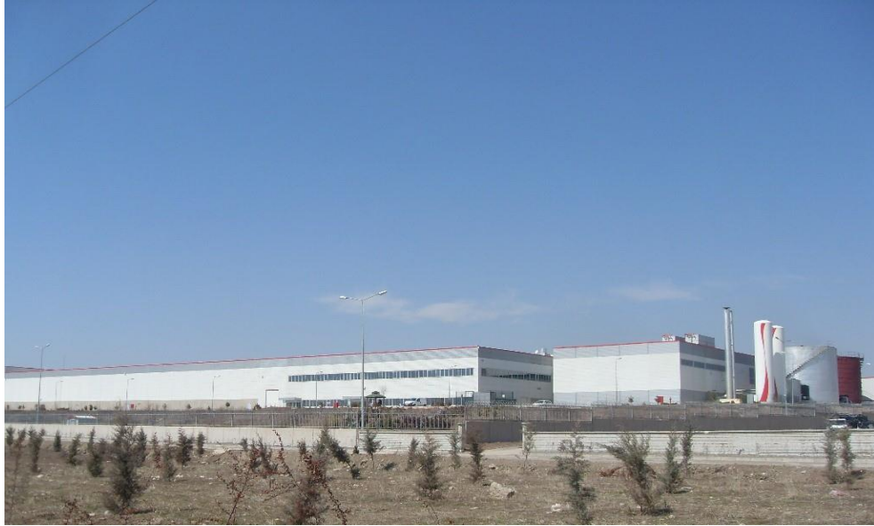
Şekil 2.1. Gazlı içecek fabrikasının dıştan görünümü
