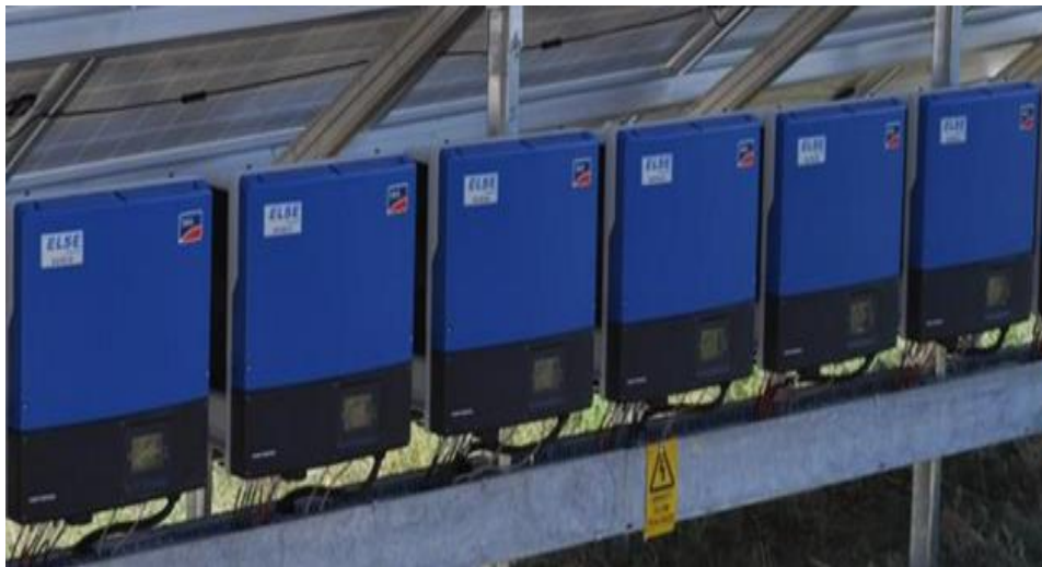
Şekil 2.7. Dizi tipi inverterler
