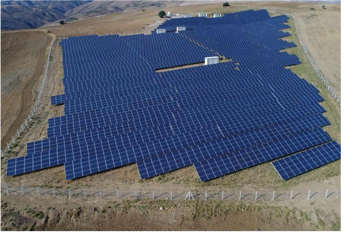
Şekil 5.1. 3,6 MWp kapasiteli güneş enerjisi santrali
