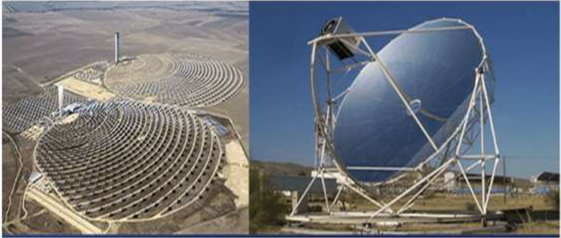
Şekil 1. 9. Merkezi alıcı ve çanak tip güneş kollektör sistemleri
