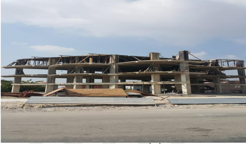
Şekil 4.6. Bina Kat Kenarlarının Mevcut Durumu İle İlgili Resim
