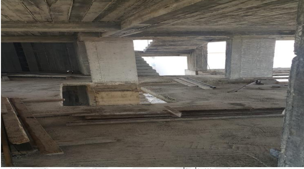
Şekil 4.5. Bina Kat Kenarlarının Mevcut Durumu İle İlgili Resim
