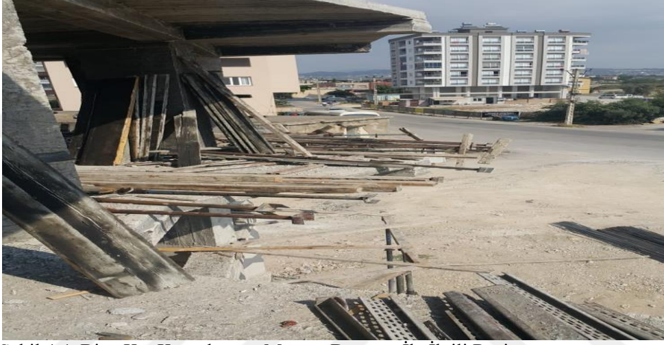
Şekil 4.4. Bina Kat Kenarlarının Mevcut Durumu İle İlgili Resim
