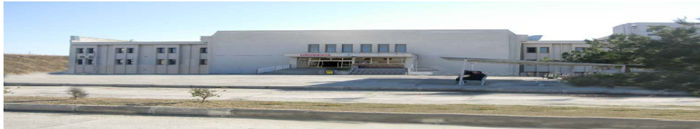
Resim 5.2. Hastane Poliklinik giriş kapısı iyileştirilmiş sonraki hali
