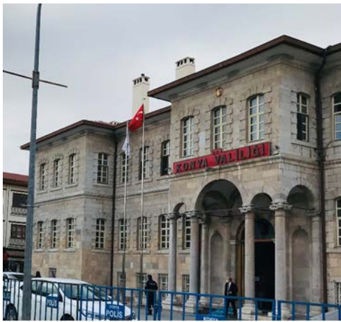
Fotoğraf 3.21. Konya Valilik Binası
