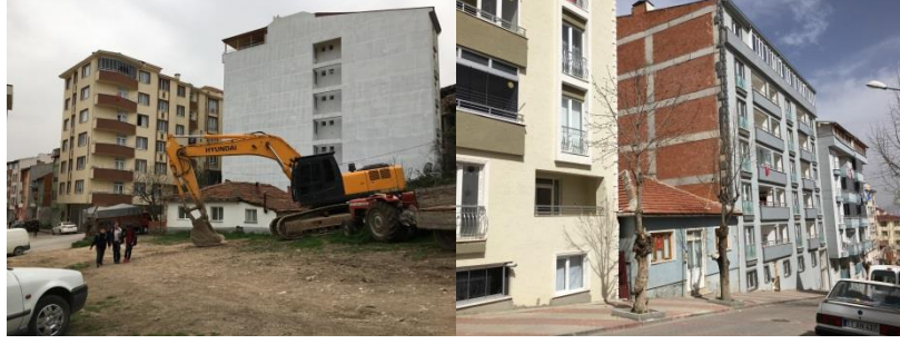
Şekil 50. 141. Bölgedeki İnşa Faaliyetleri ve Yeni Konutlar
