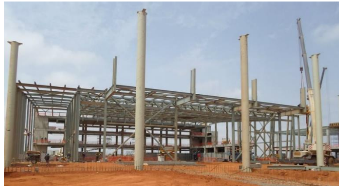
Şekil 4. 10: Saçığı taşıyan spiral kolonlar.
