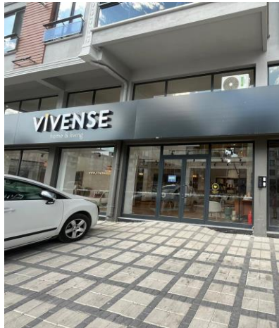
Şekil 13. Vivense Afyon Showroom Dış Cephe Tasarımı
