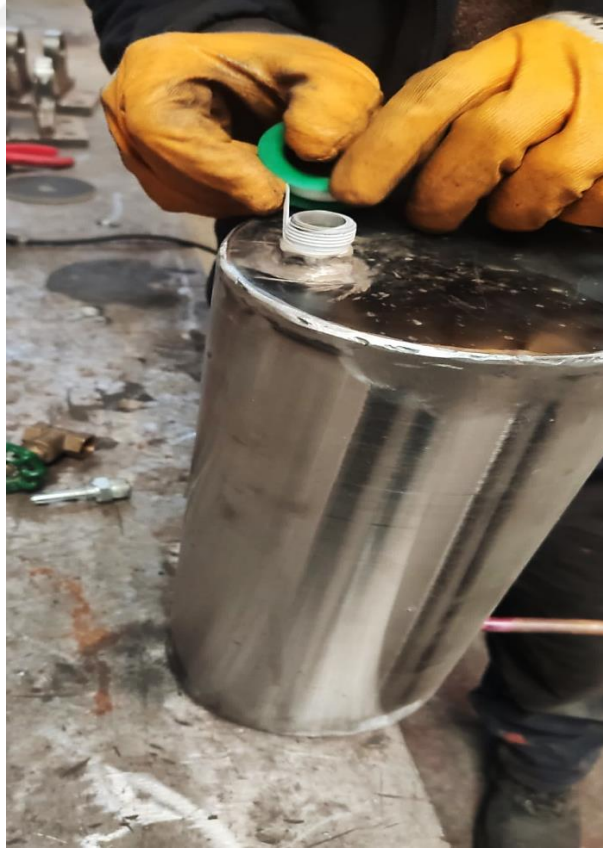
Şekil 4. 16: Isı değıştirici flanşların kapatılması
