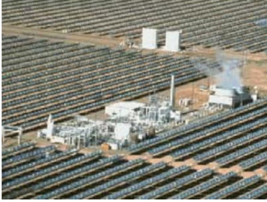
Resim 2.1. Parabolik oluklu kollektör [30]
