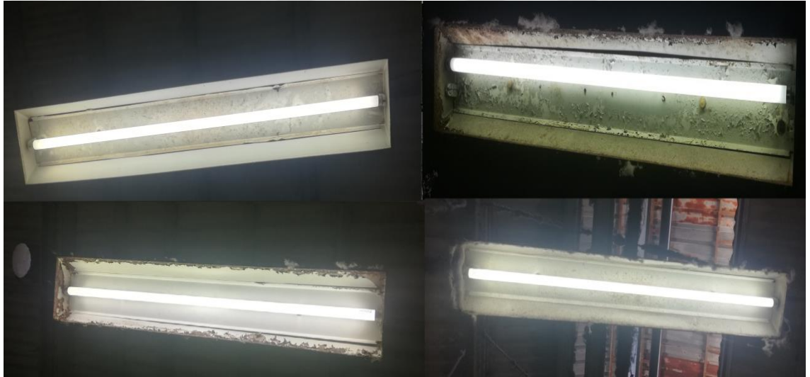
Şekil 4.4. Armatür kaynaklı aydınlatma verimsizliğine neden olan örnek armatürler.
