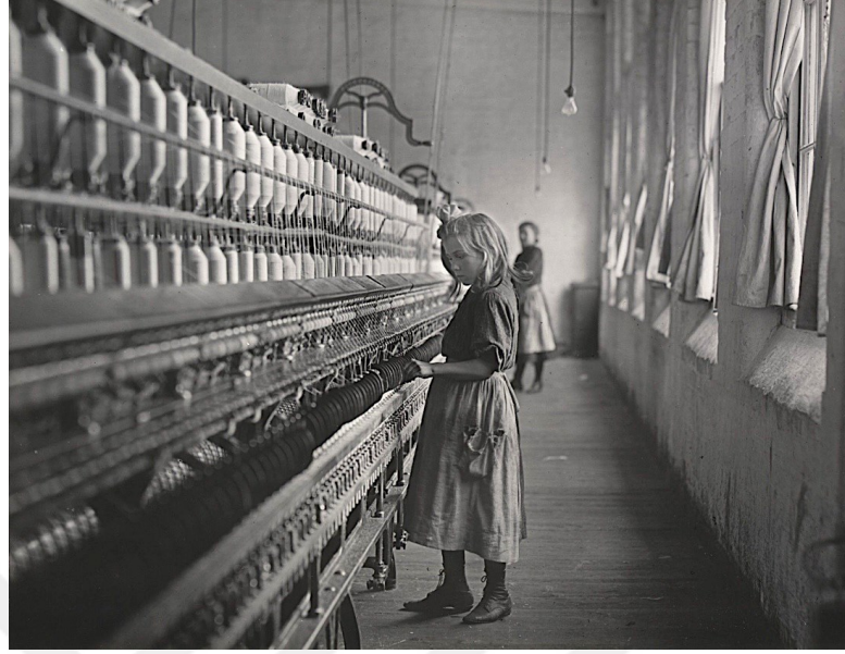
Şekil 5. Lewis Hine, Lancaster İplik Fabrikası, 1911
