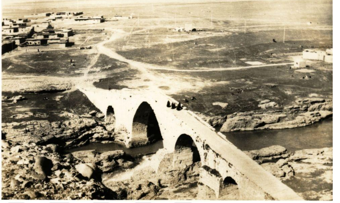
Ek-6: Zaho kentinde bulunan Delal Köprüsü'nün bir fotoğrafı.
