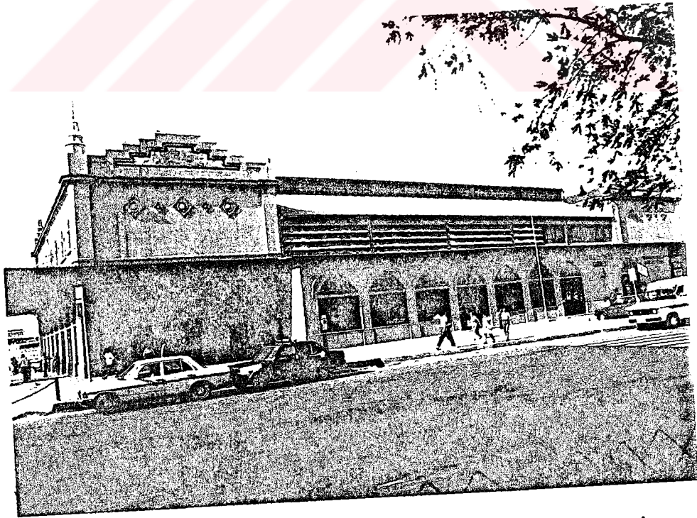
Resim 2.146. Aynı bina arka cephe, Haldun Taner sahnesine dönüştürüldükten sonra.
