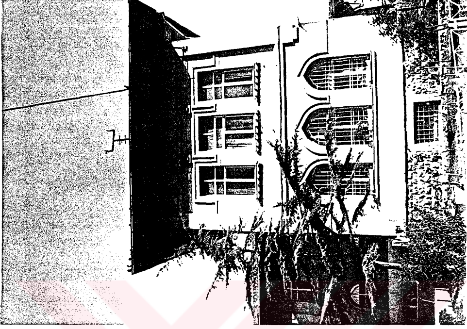
Resim 2.132. Aynı bina, ana caddeneye dik konumlanmış koldaki cephe.
