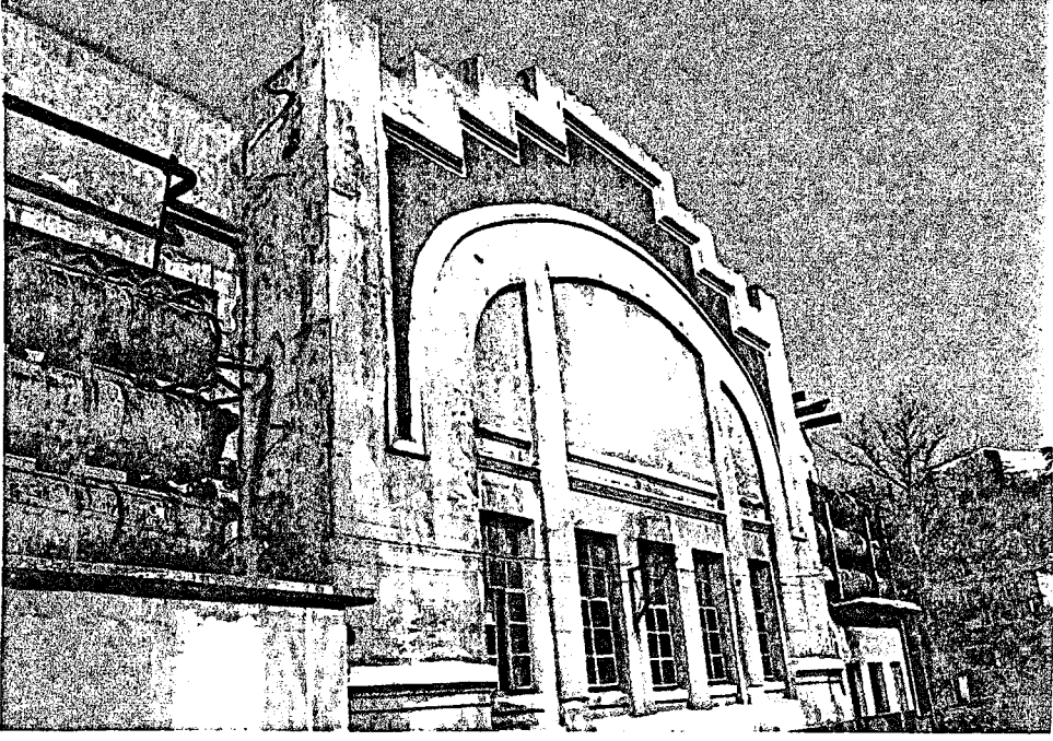
Resim 2.148. Sütlüce Mezbahası, yan cepheden detay.
