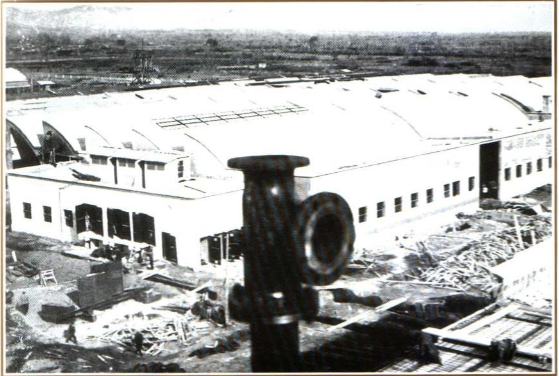
Vazilli Basma Fabrikası inşaatından bir görünüş (1937)
