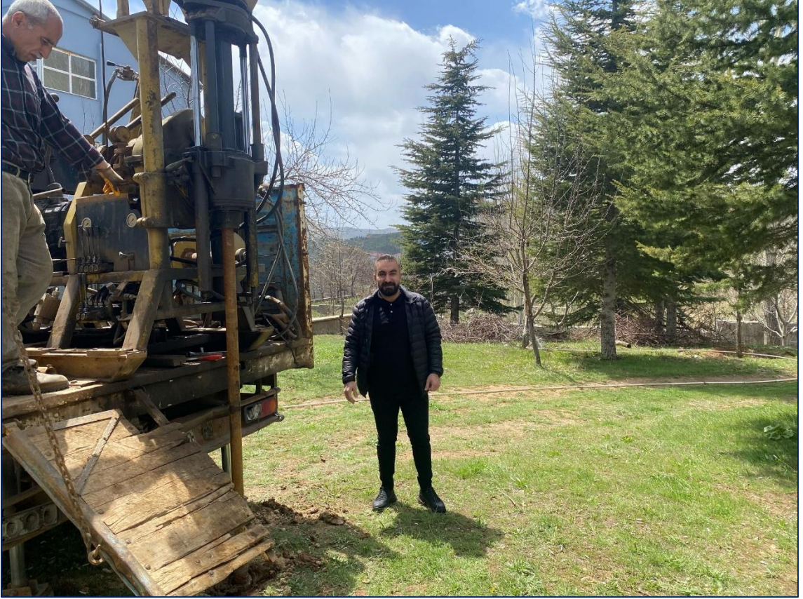
Şekil 4.9. İnceleme alanında yapılan sondaj çalışmalarından görünüm
