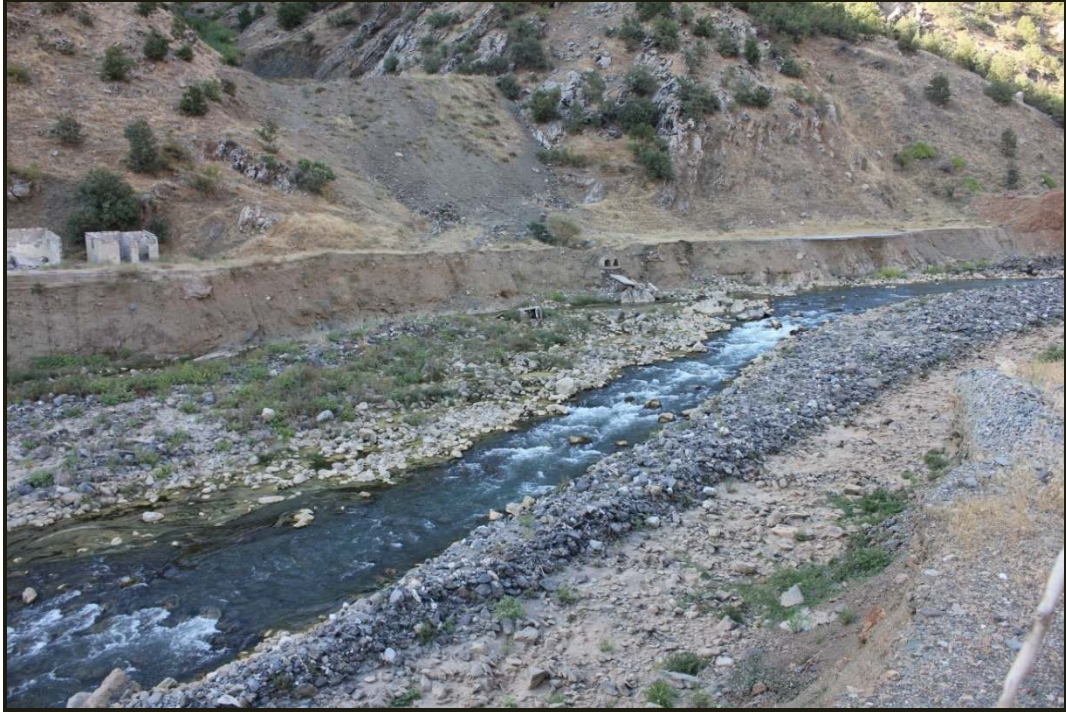
Şekil 4.16. Regülatör alanında gözlenen alüvyonlar
