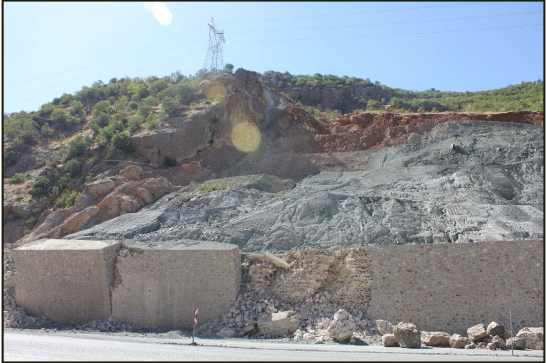
Şekil 4.69. Bitlis-Diyarbakır karayolunda Guleman ofiyolitlerinde serpantinitlerin neden olduğu heyelan ve yıkılan istinat duvarı
