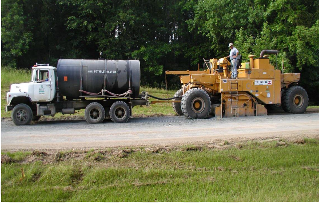
Şekil 1.17. Çimento katılarak yapılan tam derinlikli geri dönüşüm uygulaması – Natchez Trace Park yolu Mississippi – USA [6].
