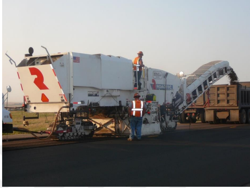
Şekil 1.3. Soğuk düzeltme ve kazınan malzemenin kamyonlara yüklenip sahadan uzaklaştırılması [70].
