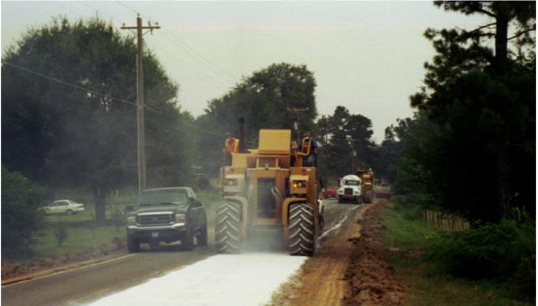
Şekil 1.18. Kireç kullanılarak yapılan tam derinlikli geri dönüşüm uygulaması – Dominik Cumhuriyeti [6].
