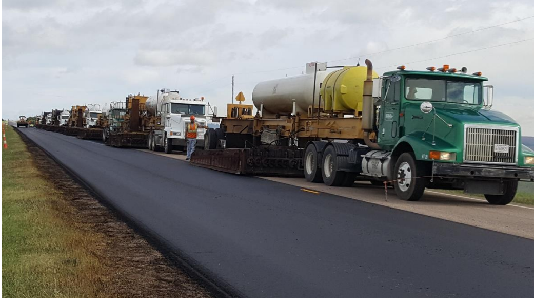
Şekil 1.4. Yerinde sıcak geri dönüşüm yöntemi [74].
