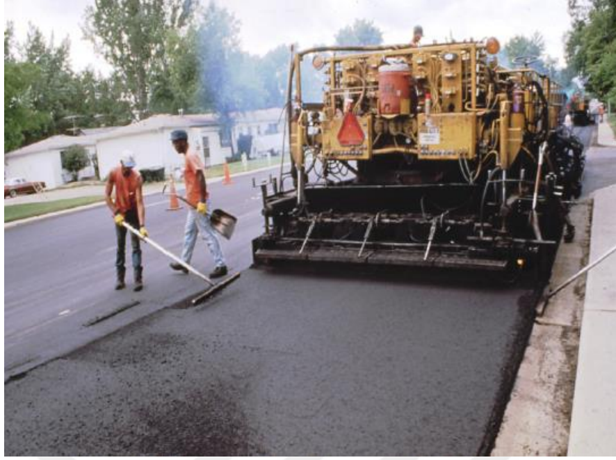
Şekil 1.8. Yeniden kaplama uygulaması [72].
