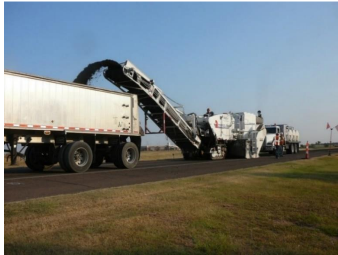
Şekil 1.2. Soğuk düzeltme yöntemi [70].
