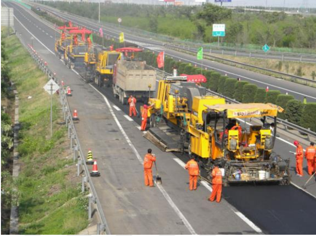
Şekil 1.6. Yerinde sıcak geri dönüşüm uygulamasının iş makineleri [73].
