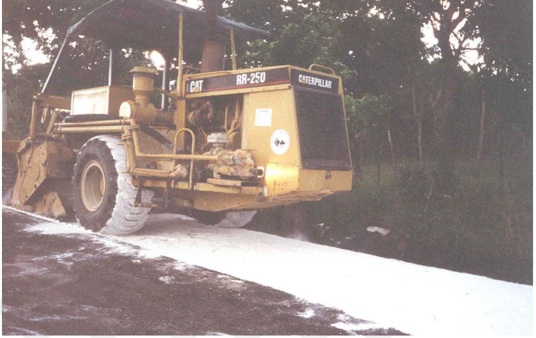
Şekil 1.19. Kireç ve köpük bitüm katkısı kullanarak yapılan tam derinlikli geri dönüşüm uygulaması – Kanada [6].
