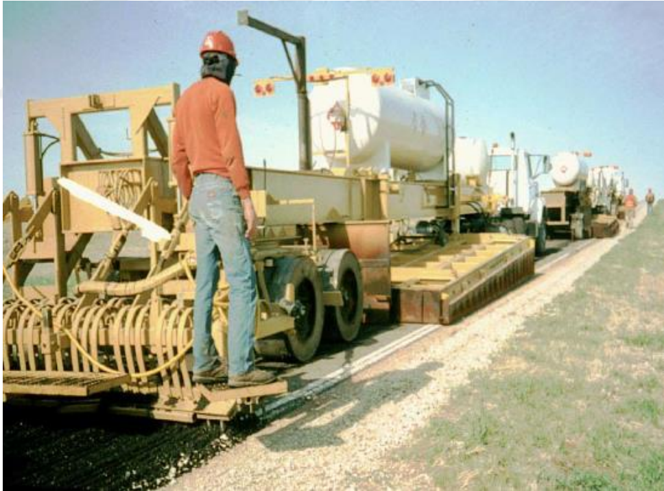
Şekil 1.5. Yerinde sıcak geri dönüşüm uygulaması [72].
