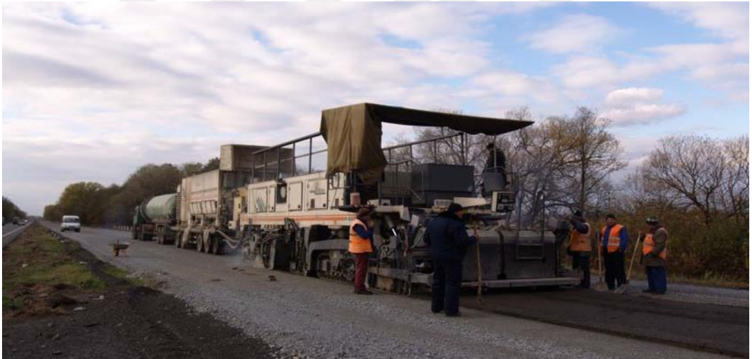
Şekil 1.20. Bitüm emülsiyon ve granüler malzemesi kullanılarak yapılan tam derinlikli geri dönüşüm yöntemi – Ukrayna [6].
