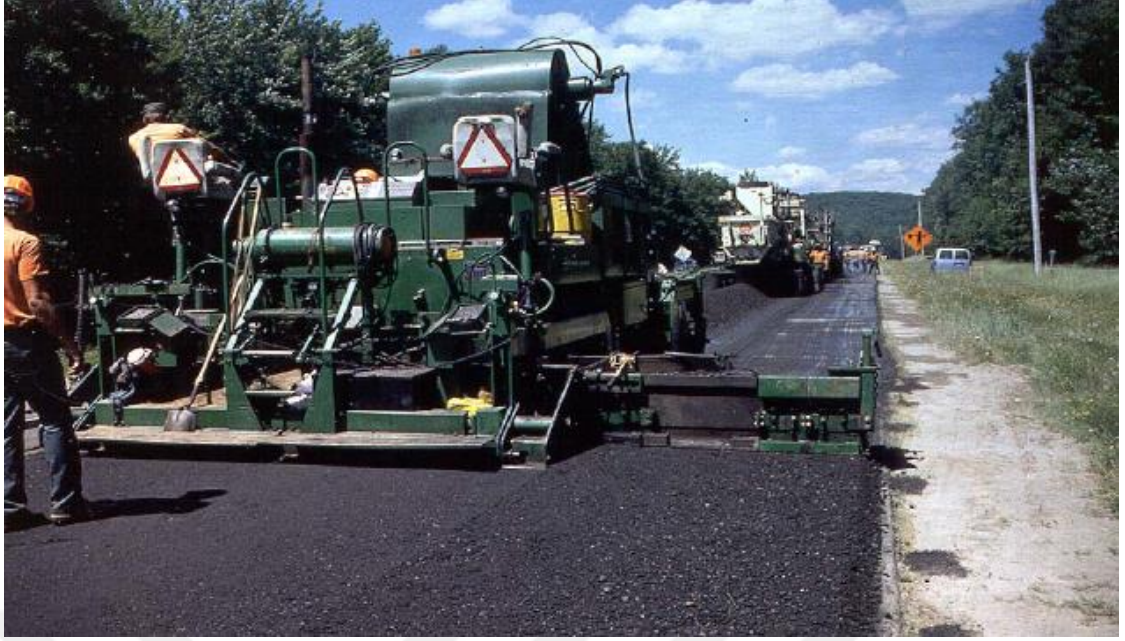
Şekil 1.10. Yerinde soğuk geri dönüşüm yöntemi [72].
