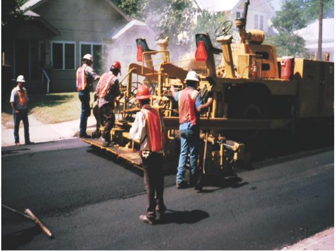
Şekil 1.7. Yüzeysel geri dönüşüm uygulaması [72].
