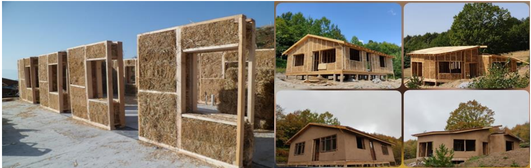
Şekil 2.34: yapılarda saman kullanımı ve toprak sıvama uygulama örneği (UR-11)
