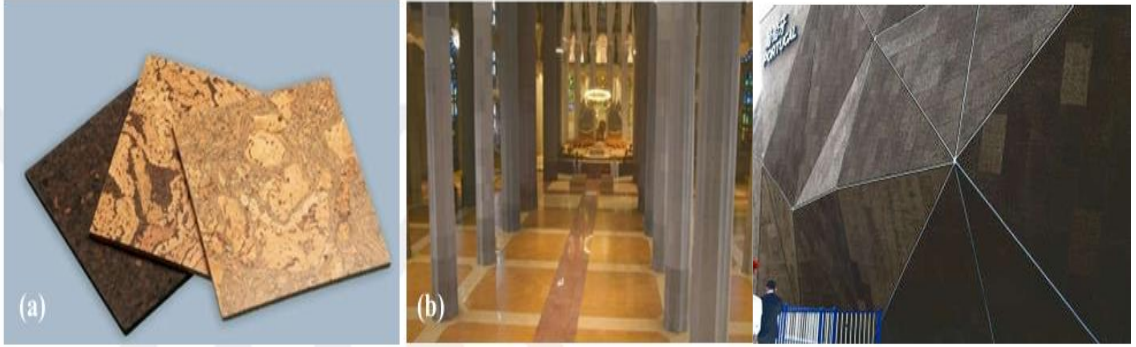
Şekil 2.26 (a) Mantar zemin kaplama malzemesi (Reinhardt, t.y.) ve (b) Sagrada Familia Katedrali'nde uygulanan mantar zemin kaplama (c) mantar paneli cephe kapla (Koçak, 2022)
