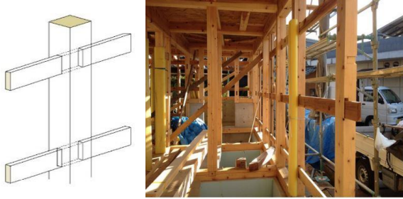
Şekil 4.31. Nuki Geleneksel Japon Ahşap Birleştirme Tekniği (Anonymous 22)
