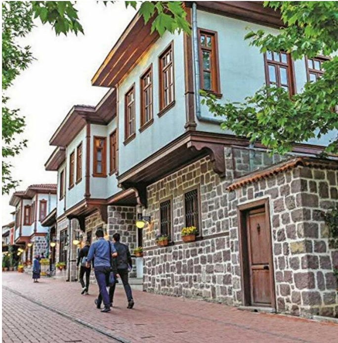
Şekil 4.15. Geleneksel Türk Evi Avlu Duvarı (Anonim 6)
