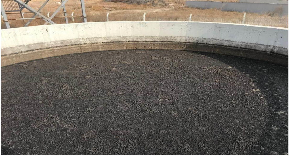
Şekil 2.3. Bulamaç kıvamına gelmiş tank içi görüntü
