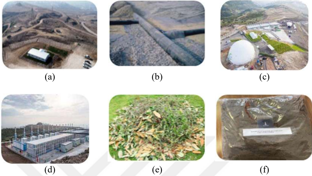
ekil 3.11. Harmandalı DADT a)2800 ton/gn atık kabul, b)gaz toplama rigolleri ve sızıntı suyu drenaj hatları imalatı, c)gaz toplama niteleri (buster ve chiller nitesi ile gaz balonu), d)elektrik retimi, e)kompostlařtırılacak atıklar ve f)kompost retimi
