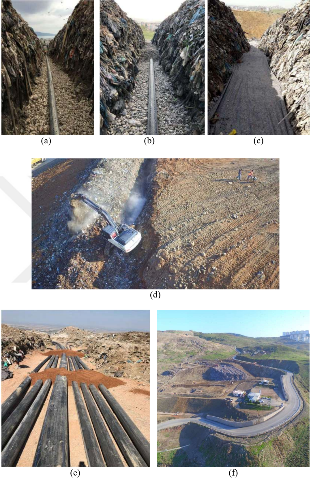
Şekil 3.16. Harmandalı DADT'deki a, b, c) rigol hatlarının yerleştirilmesi işlemi, d) rigol hatlarının kazılması işlemi, e) motorlara gazı taşıyan ana rigol hatlarının imalat işlemleri ve f) çöplerin platformlarda depolanması ve serme/sıkıştırma işlemi
