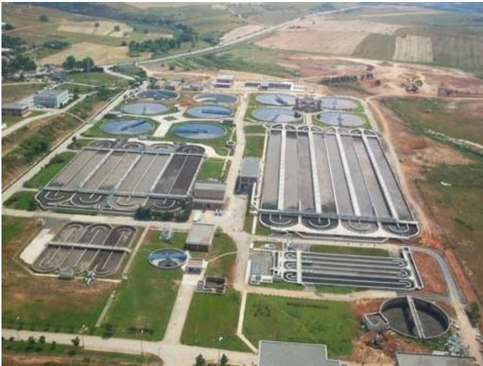
Şekil 2.3 : İnceleme Yapılan Atıksu Arıtma Tesisi.
