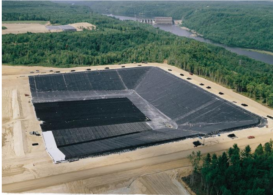
Görsel 2.5 Şehir çöplüğü düzenli depolama sızdırmaz membran [1]
