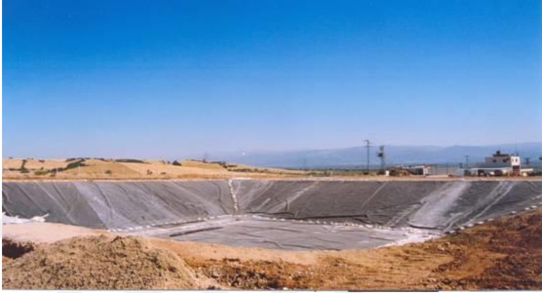
Görsel 2.6. Düzenli depolama sahası membran görünümü
