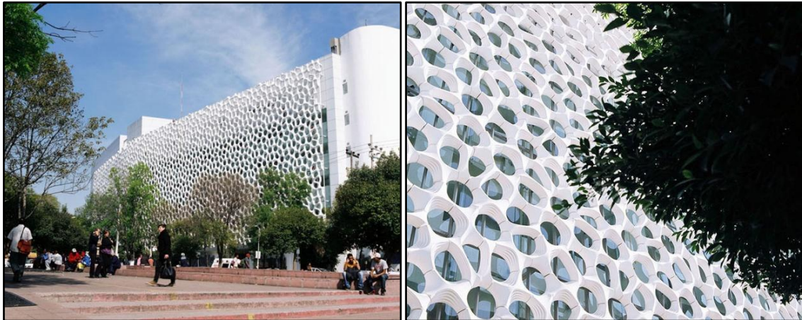
Figure 2.10. Torre de Especialidades Hospital facade [28].
