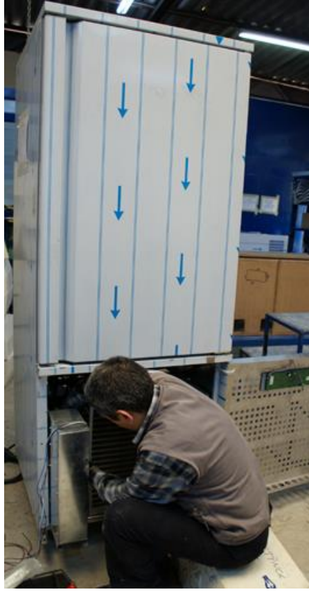
Şekil 5.8 : Blast Freezer için soğutma grubu ve elektrik montajı
