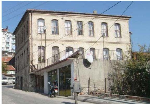
Fotoğraf 154: Yapıdan güneybatı cephe
