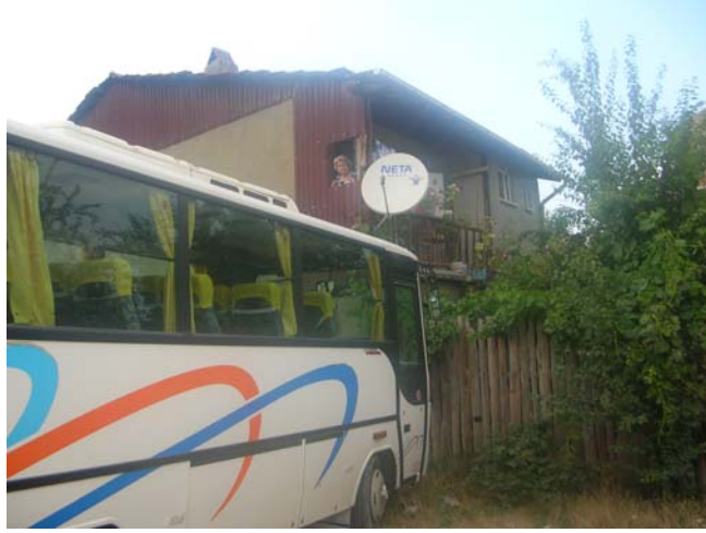
Fotoğraf 129: Yapıdan güneydoğu cephe
