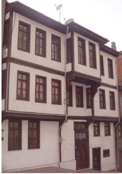
Fotoğraf 86: Yapıdan batı cephe
