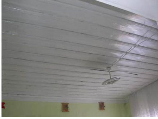
Fotoğraf 478–479: Emine Tağcı Evi çakma tekniğinde, Yeşil Konak’tan aplike tekniğinde tavan örneği
