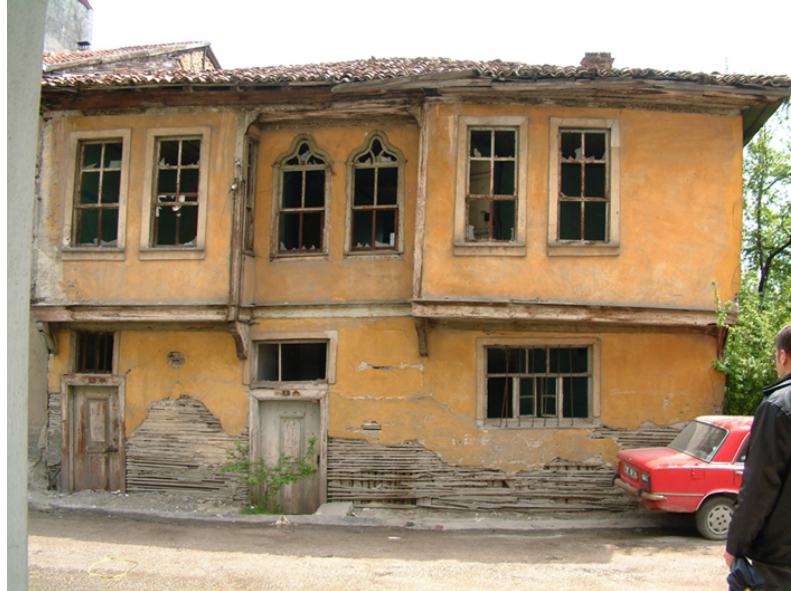
Fotoğraf 88: Yapıdan genel görünüm
