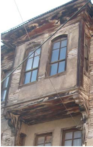
Fotoğraf 390: 7 Numaralı evden içi dolu ahşap konsol örneği
