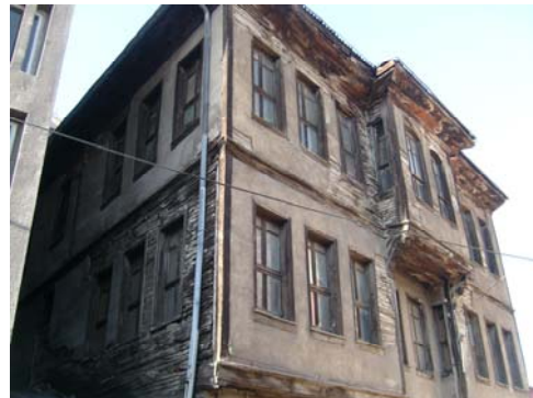
Fotoğraf 475: 7 Numaralı evden hımiş üzeri bağdadi sıvalı teknik
