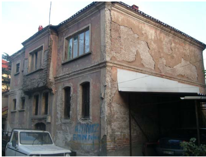
Fotoğraf 158: Yapıdan güneydoğu ve kuzeydoğu görünüm
