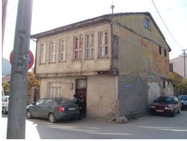
Fotoğraf 101: Yapıdan güneybatı cephe
