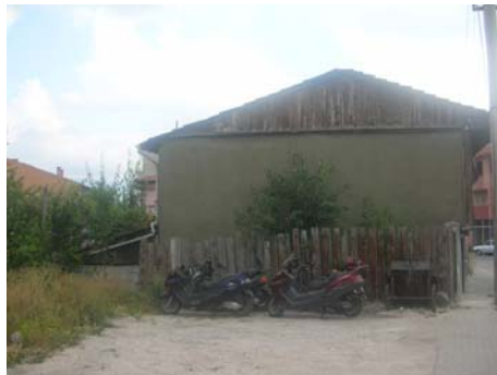
Fotoğraf 128: Yapıdan güneybatı cephe
