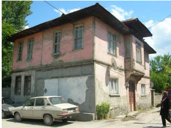
Fotoğraf 202: Yapıdan güneydoğu ve güneybatı cephe
