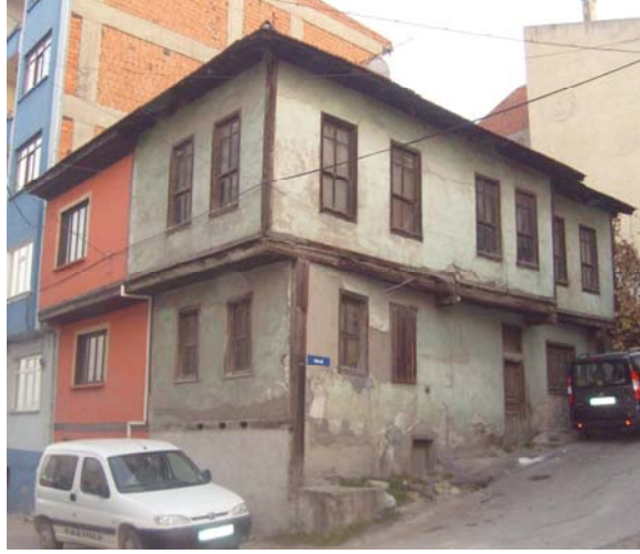
Fotoğraf 76: Yapıdan kuzeybatı cephe
