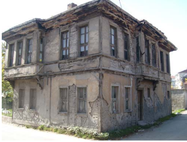
Fotoğraf 109: Yapıdan güneybatı cephe
