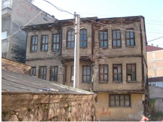
Fotoğraf 46:Yapıdan güneybatı cephe
