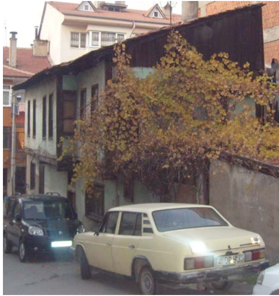
Fotoğraf 77: Yapıdan güney cephe
