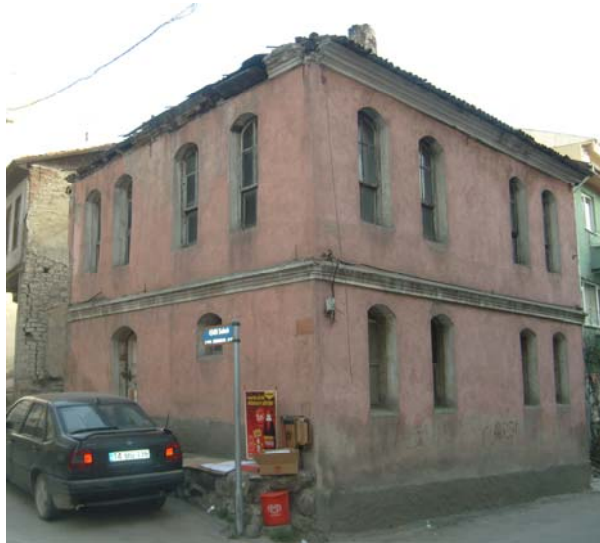
Fotoğraf 294:Yapıdan kuzeybatı cephe görünümü
