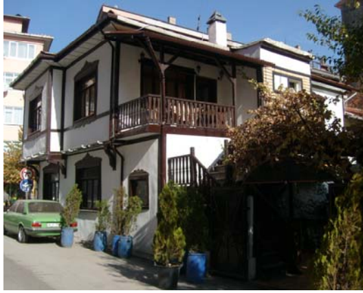
Fotoğraf 222: Yapıdan kuzeybatı cephe
