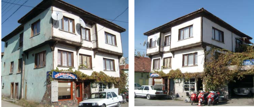
Fotoğraf 36–37: Yapının güneybatı ve kuzeydoğu cepheleri
