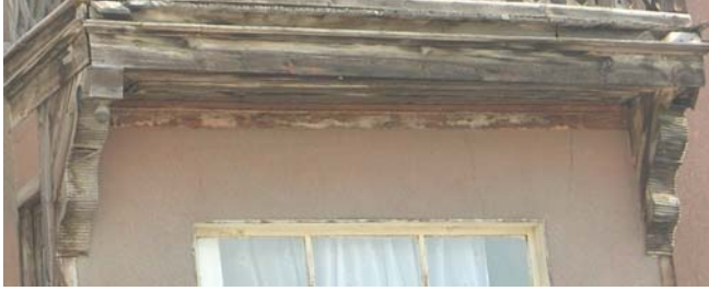
Fotoğraf 63: Çıkma altı desteği
