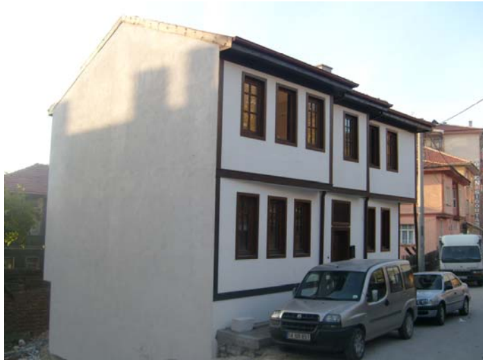
Fotoğraf 281: Yapıdan kuzeybatı görünüm
