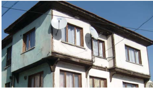
Fotoğraf 34: Yapının çıkması ve çıkma destekleri
