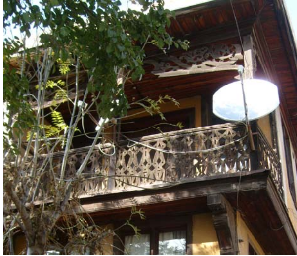
Fotoğraf 141: Yapıdan balkon ve balkon korkuluğu
