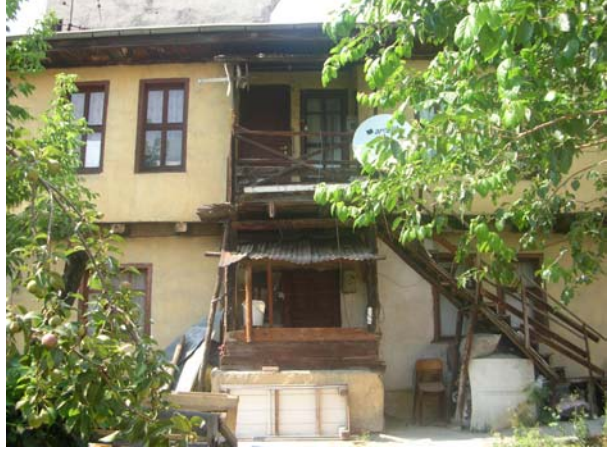
Fotoğraf 394: 1 Numaralı evden ahşap kirişle destekli çıkma
