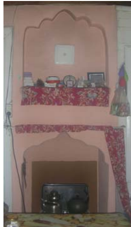
Fotoğraf 442: 19 Numaralı evden kaş kemer-beş dilimli kemerden oluşan ocak
