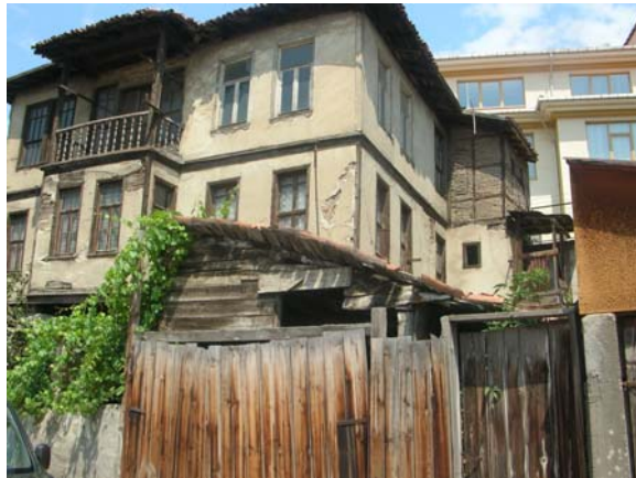
Fotoğraf 135:Yapıdan güneydoğu cephe
