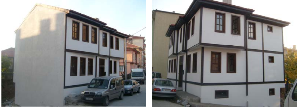
Fotoğraf 291–292: Yapıdan kuzeybatı cephe ve güney cephe görünümü
