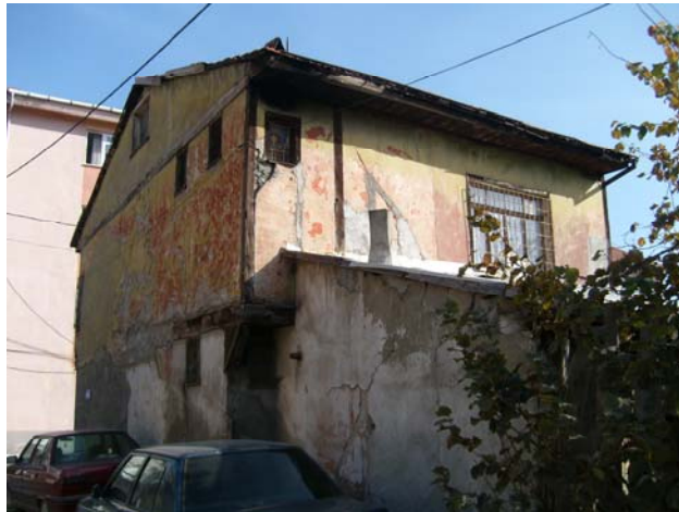
Fotoğraf 103: Yapıdan güneydoğu cephe
