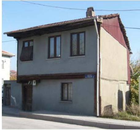
Fotoğraf 127: Yapıdan kuzeybatı cephe
