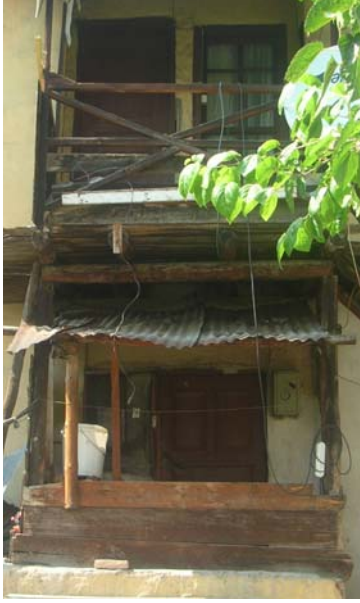
Fotoğraf 472–473: 1 ve 2 Numaralı evlerden sac malzeme kullanımı
