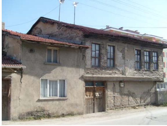
Fotoğraf 8: Yapıdan kuzeybatı görünüm
