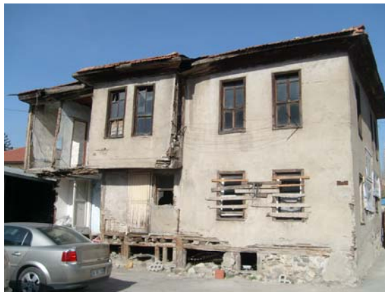
Fotoğraf 12:Yapıdan kuzeydoğu cephe
