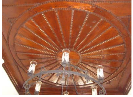
Fotoğraf 478–479: Emine Tağcı Evi çakma tekniğinde, Yeşil Konak’tan aplike tekniğinde tavan örneği
