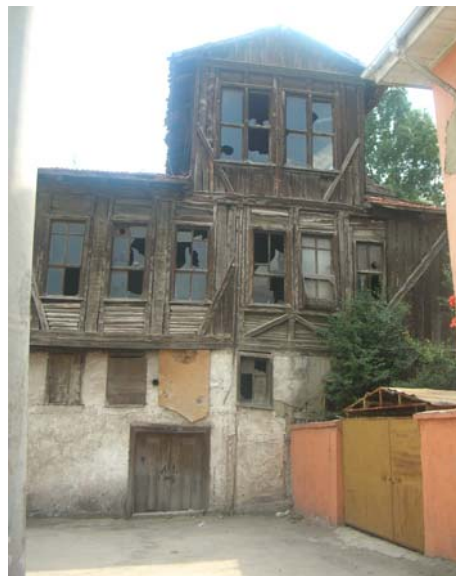
Fotoğraf 186: Yapıdan güneybatı cephe
