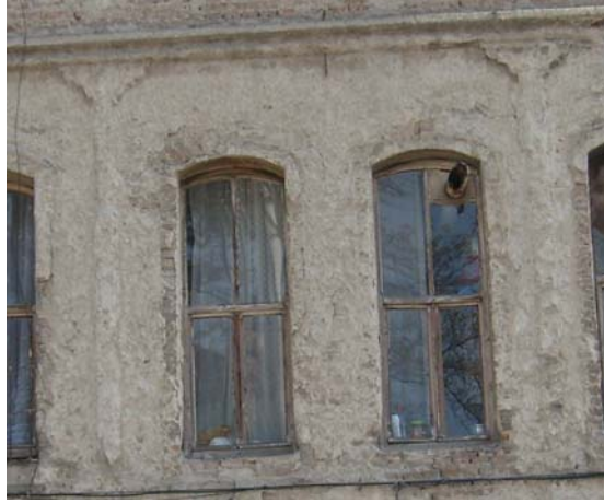
Fotoğraf 151: Yapıdan kemerli pencere örneği
