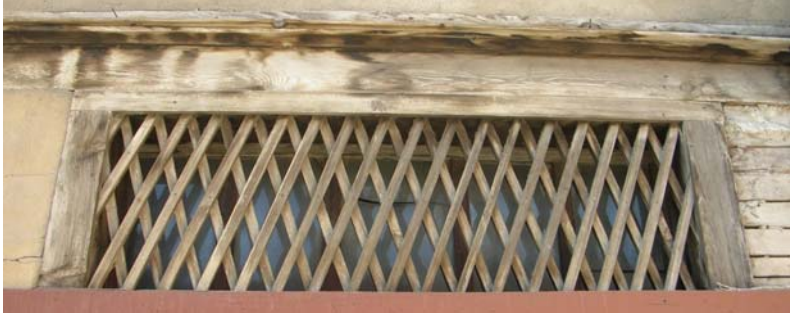
Fotoğraf 489: 7 Numaralı evden ahşap çıtalarla yapılan kafes tekniği
