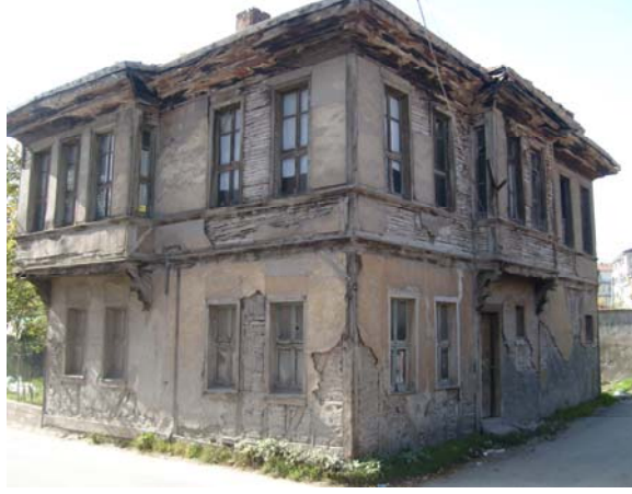
Fotoğraf 476: 16 Numaralı evden alt kat hıms, üst kat hıms üzeri bağdadi sıva
