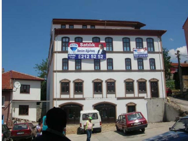
Fotoğraf 227:Yapıdan batı cephe
