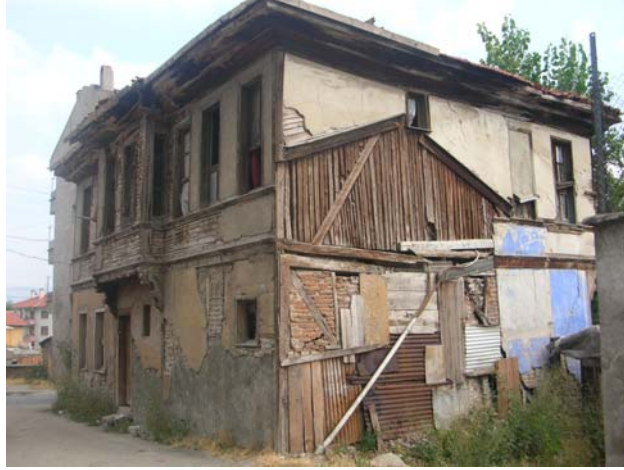
Fotoğraf 110: Yapıdan güneydoğu cephe
