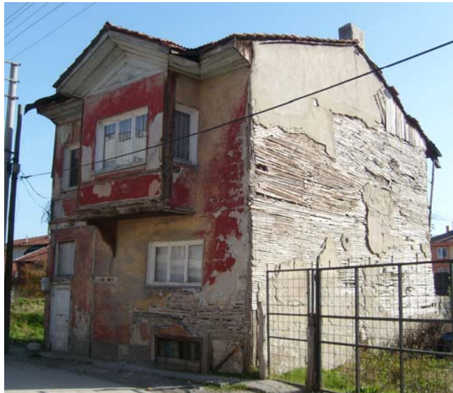
Fotoğraf 65:Yapıdan güneydoğu görünüm
