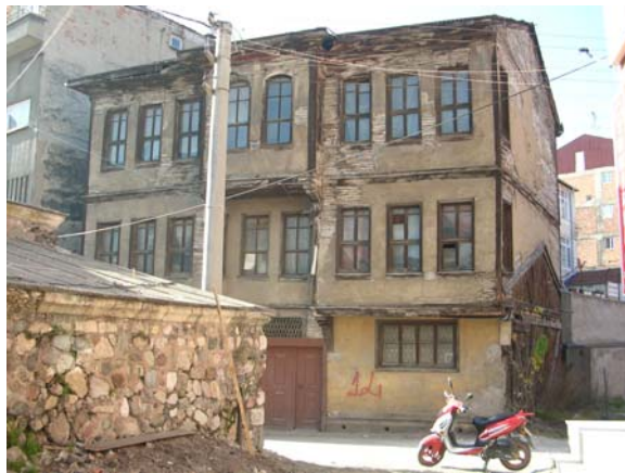
Fotoğraf 38:Konuttan güneybatı görünüm
