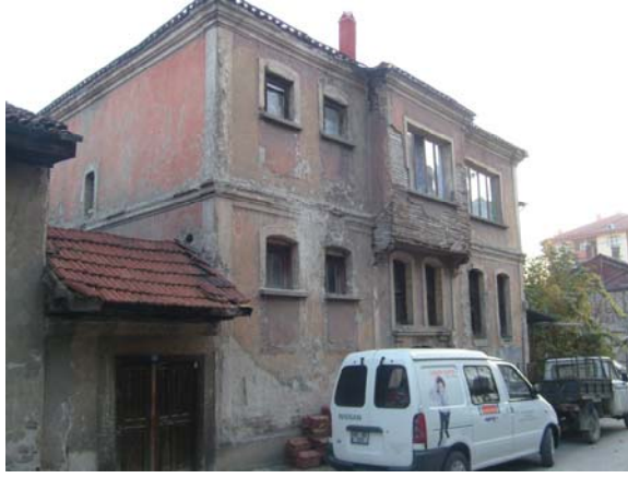
Fotoğraf 166: Yapıdan güneybatı ve güneydoğu görünüm
