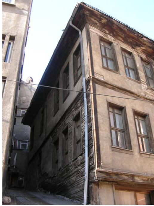
Fotoğraf 47: Yapıdan kuzeybatı cephe
