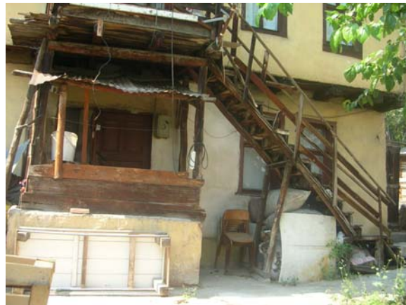
Fotoğraf 3:Yapıdan kuzeybatı görünüm
