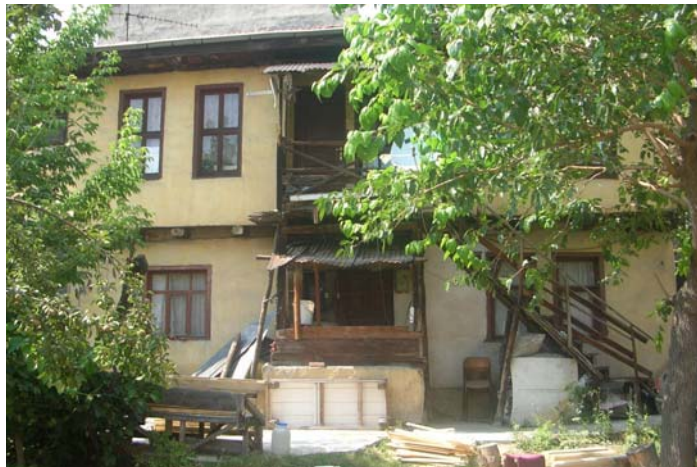
Fotoğraf 1: Yapıdan kuzeybatı görünüm
