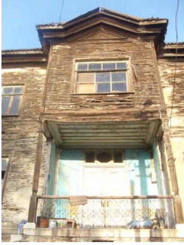
Fotoğraf 393: 25 Numaralı evden ahşap direklerle taşınan çıkma
