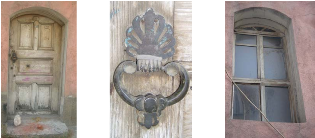
Fotoğraf 297–298–299:Yapıdan ana giriş kapısı, kapı tokmağı ve pencere detayı
