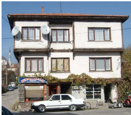
Fotoğraf 35: Yapının güneydoğu cephesi
