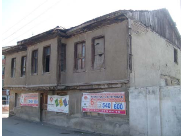
Fotoğraf 14:Yapıdan güneydoğu cephe
