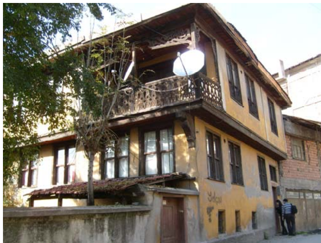
Fotoğraf 136: Yapıdan kuzeybatı görünüm
