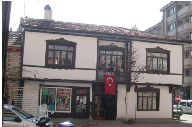
Fotoğraf 204: Yapıdan güneydoğu cephe
