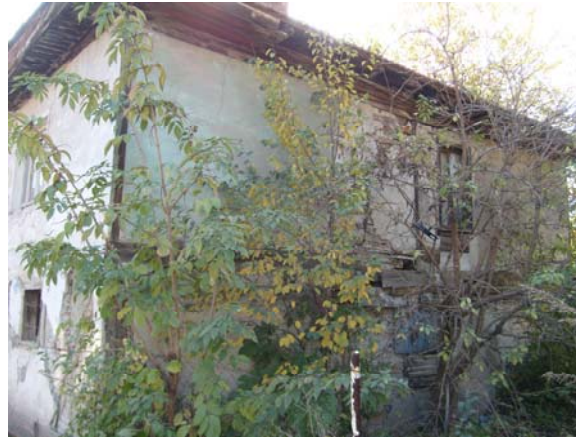
Fotoğraf 23: Yapıdan güney cephe
