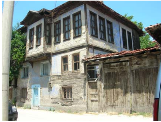
Fotoğraf 197:Yapıdan güneybatı ve kuzeydoğu cephe
