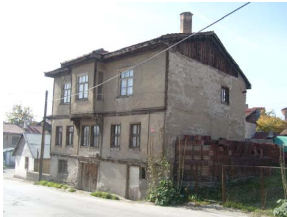
Fotoğraf 120: Yapıdan güneydoğu cephe
