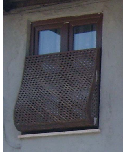
Fotoğraf 487–488: 24 ve 19 Numaralı evlerden ahşap çıtalarla yapılan kafes tekniği
