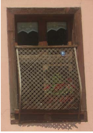
Fotoğraf 487–488: 24 ve 19 Numaralı evlerden ahşap çıtalarla yapılan kafes tekniği
