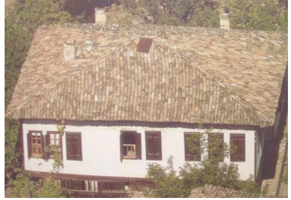
Fotoğraf 400: Bolu Mengen’den beşik çatı Fotoğraf 401: Safranbolu’dan kırma çatı örneği (Reha Günay’dan)
