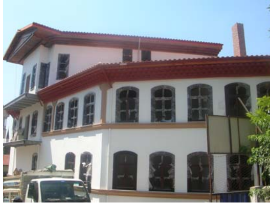
Fotoğraf 230: Yapıdan doğu cephe
