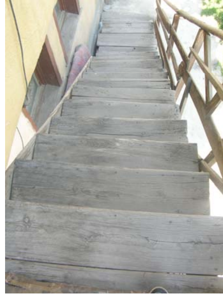
Fotoğraf 5:Yapıdan üst kata çıkış merdiveni
