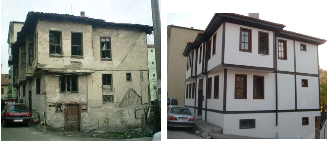
Fotoğraf 284–285: Yapıdan güney cephe eski ve yeni görünümü
