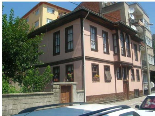
Fotoğraf 170: Yapıdan kuzeydoğu görünüm
