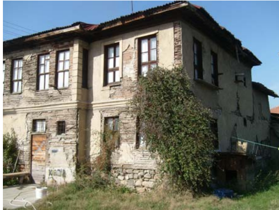
Fotoğraf 9: Yapıdan güneydoğu görünüm
