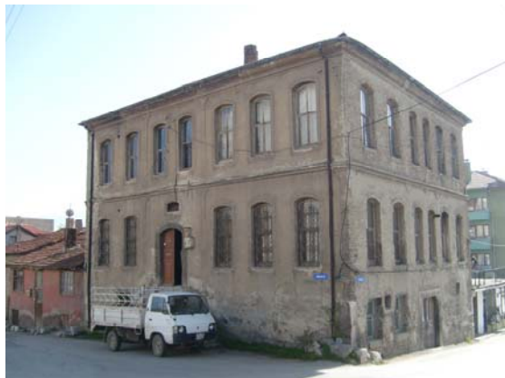
Fotoğraf 146: Yapıdan kuzeydoğu görünüm
