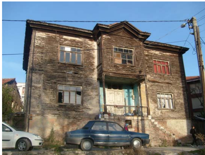
Fotoğraf 173:Yapıdan güneybatı cephe görünümü
