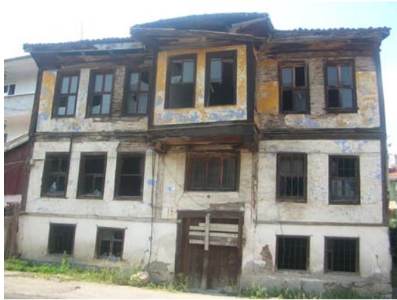
Fotoğraf 191: Yapıdan güneydoğu cephe
