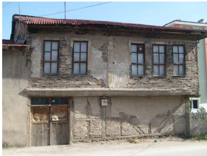
Fotoğraf 7: Yapıdan batı cephe görünümü
