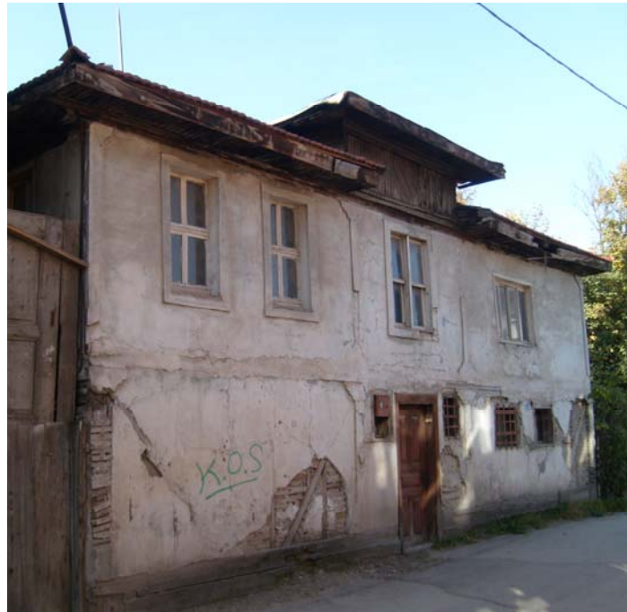
Fotoğraf 15: Yapıdan kuzeybatı görünüm
