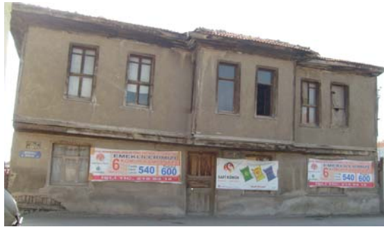
Fotoğraf 11:Yapıdan güneybatı cephe
