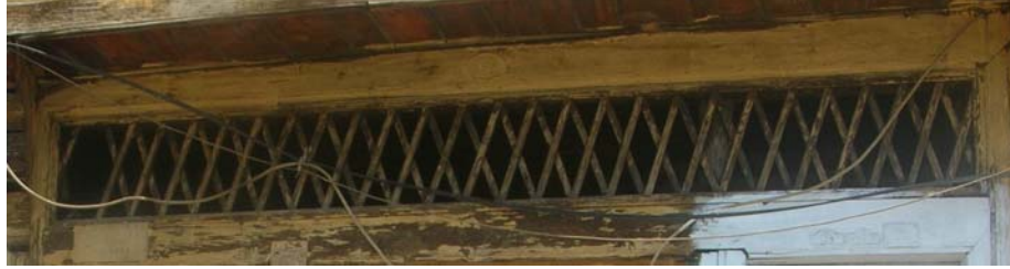
Fotoğraf 238: Yapıdan kömürlük bölümü üzerinde yer alan düzenleme
