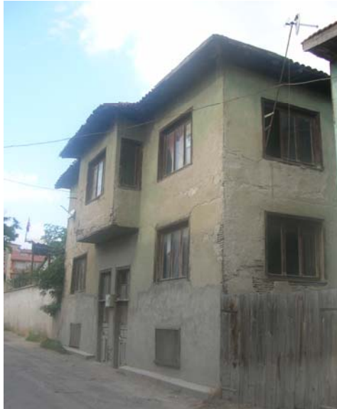
Fotoğraf 26:Yapıdan güneydoğu görünüm
