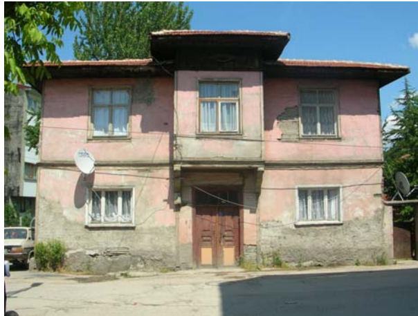
Fotoğraf 199: Yapıdan kuzeydoğu cephe
