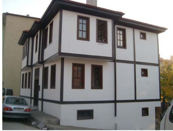
Fotoğraf 327: Mimarlar Odası Binasından bodrum kat, zemin kat ve birinci kattan oluşan üç katlı ev
