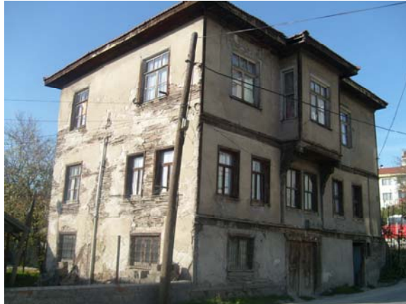
Fotoğraf 119: Yapıdan kuzeybatı cephe
