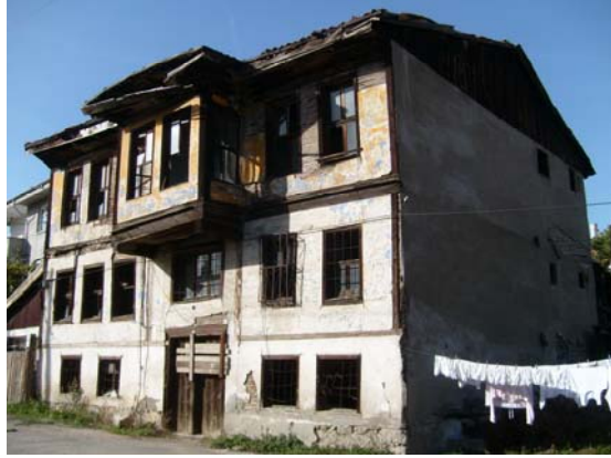
Fotoğraf 194: Yapıdan kuzeydoğu cephe
