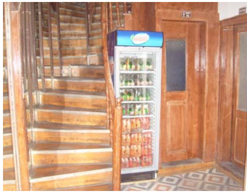
Fotoğraf 208: Yapı içinden üst kata çıkış merdiveni
