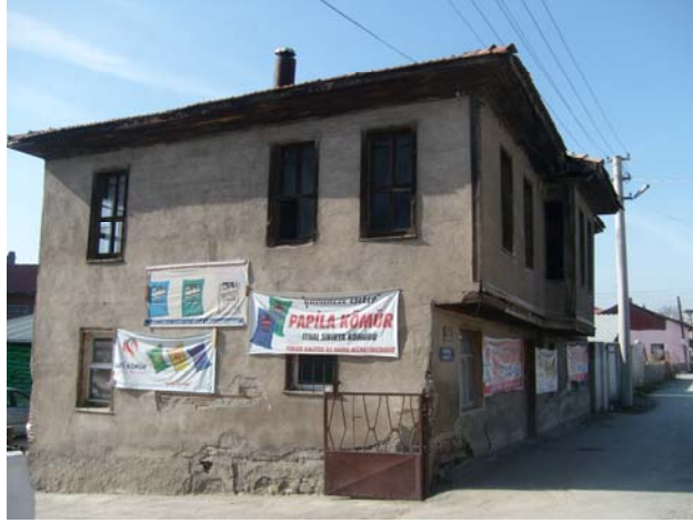
Fotoğraf 13:Yapıdan kuzeybatı cephe
