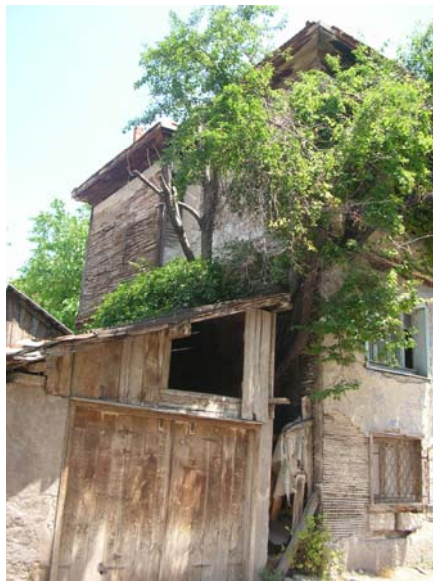
Fotoğraf 198: Yapıdan güneydoğu cephe
