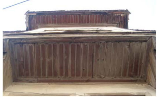
Fotoğraf 453–454: 16 ve 18 Numaralı evlerden ahşap çıkma desteği
