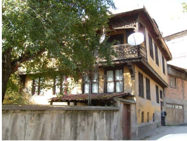
Fotoğraf 143: Yapıdan kuzeybatı cephe
