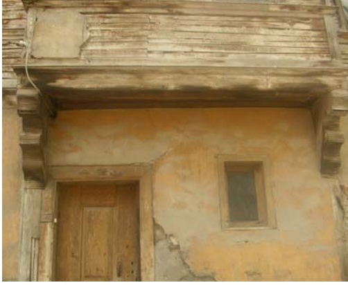
Fotoğraf 453–454: 16 ve 18 Numaralı evlerden ahşap çıkma desteği
