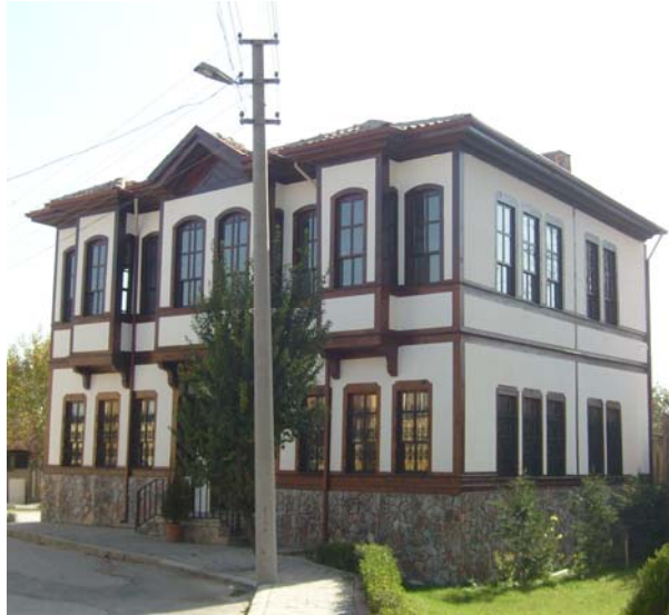
Fotoğraf 267:Yapıdan güneybatı ve güneydoğu görünüm
