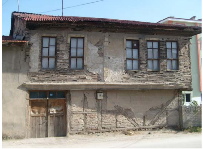
Fotoğraf 472–473: 1 ve 2 Numaralı evlerden sac malzeme kullanımı
