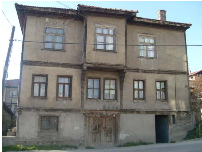
Fotoğraf 114: Yapıdan batı cephe
