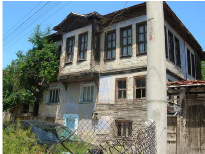
Fotoğraf 195: Yapıdan doğu cephe
