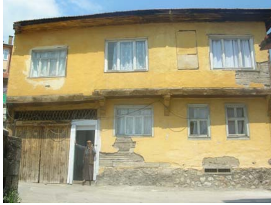
Fotoğraf 471: Emine Tağcı Evi moloz taş malzeme kullanımı
