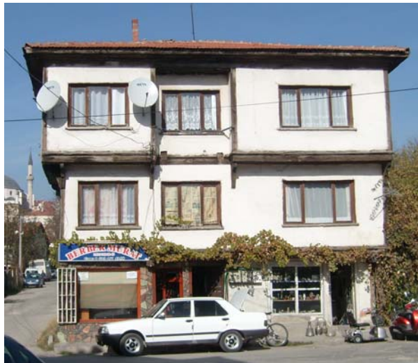
Fotoğraf 32:Yapıdan güneydoğu görünüm
