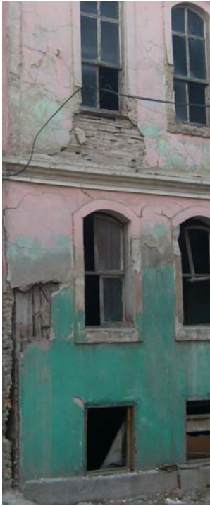
Fotođraf 306–307: Yapıdan inřa malzemesi rneđi
