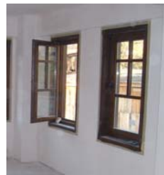
Fotoğraf 366: Mimarlar Odası Binasından içe açılan kanat biçiminde pencere örneği
