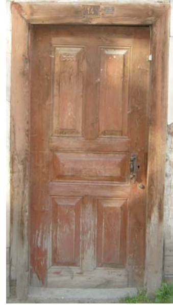
Fotoğraf 20: Yapının giriş kapısı
