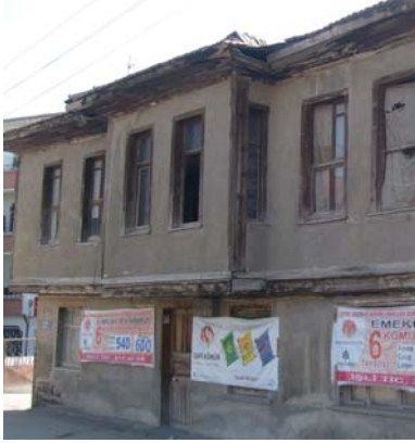
Fotoğraf 393: 25 Numaralı evden ahşap direklerle taşınan çıkma
