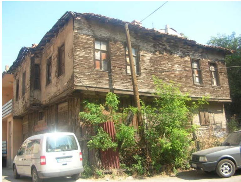
Fotoğraf 80: Yapıdan güneydoğu görünüm
