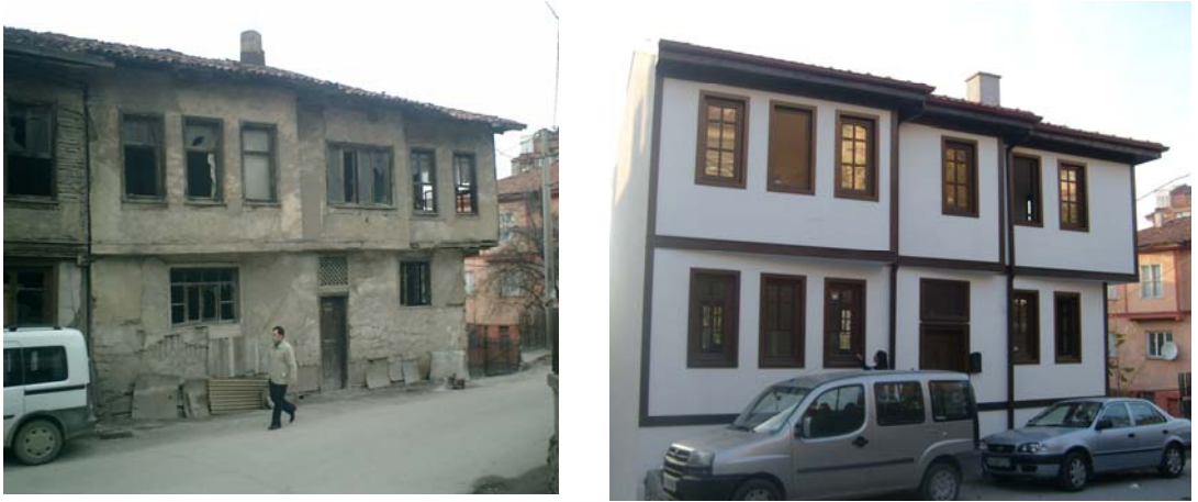
Fotoğraf 282–283: Yapıdan batı cephe eski ve yeni görünümü
