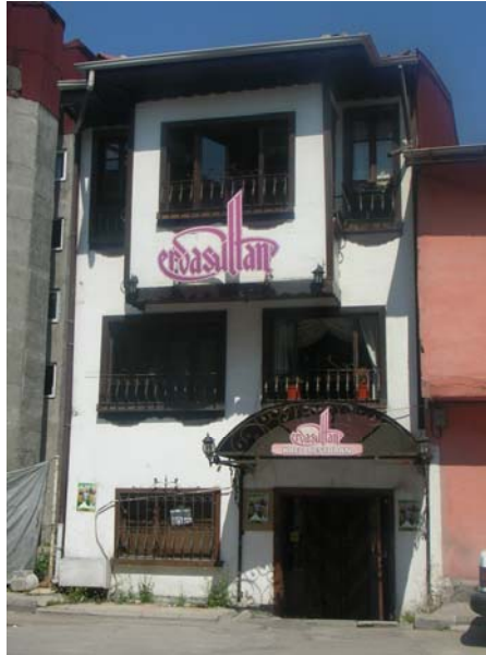
Fotoğraf 243: Yapıdan kuzeybatı cephe
