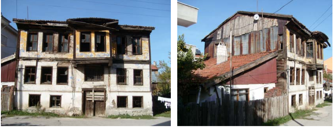
Fotoğraf 192-193: Yapıdan güneydoğu cephe ve güneybatı cephe
