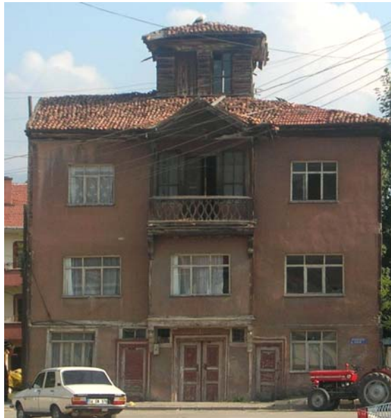
Fotoğraf 50:Yapıdan kuzey cephe görünümü
