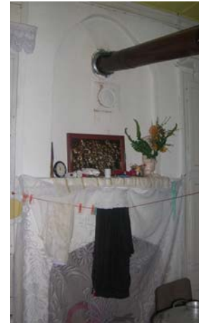
Fotoğraf 443: 23 Numaralı evden kaş kemer ve basık sivri kemerden oluşan ocak
