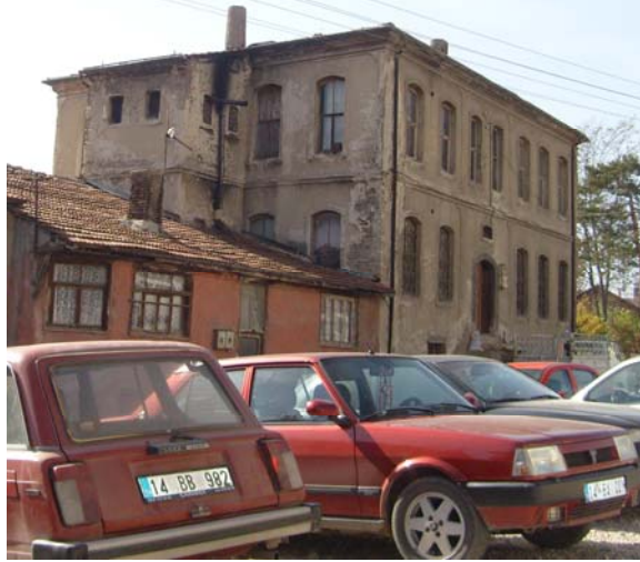
Fotoğraf 153: Yapıdan güneydoğu cephe
