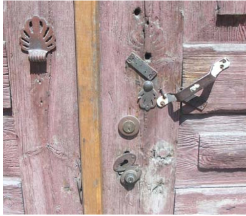
Fotođraf 203: Yapıdan kapı tutacađı ve kapı tokmađı
