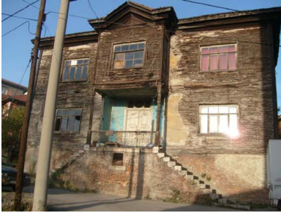
Fotoğraf 467: 25 Numaralı evden tuğla kullanımı Fotoğraf 468: Fethiye Sarı Bina’dan tuğla kullanımı
