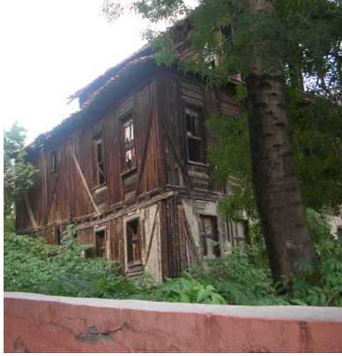
Fotoğraf 190: Yapıdan güneydoğu cephe
