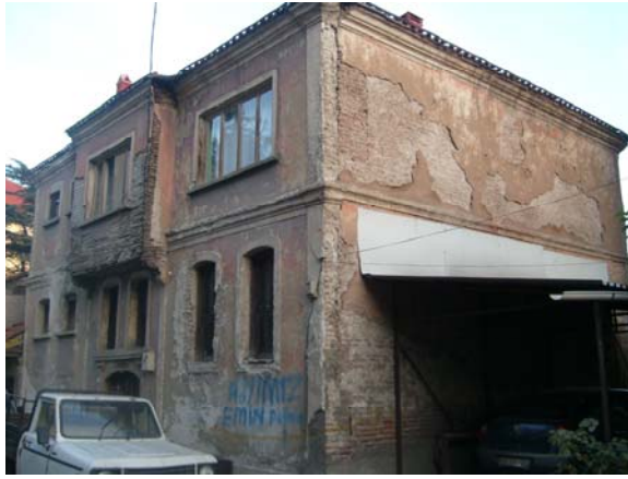
Fotoğraf 167: Yapıdan kuzeydoğu cephe
