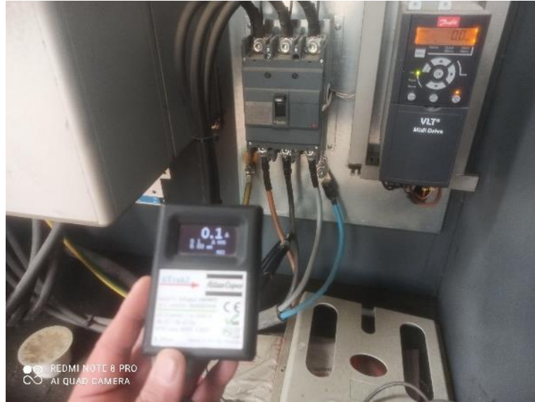
Şekil 2.3. Kompresörlerin yükte-boşta çalışma süresi tespiti (Atlas Copco, 2024)
