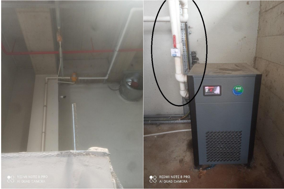
Şekil 3.8. Mevcut hava hatlarının görünümü
