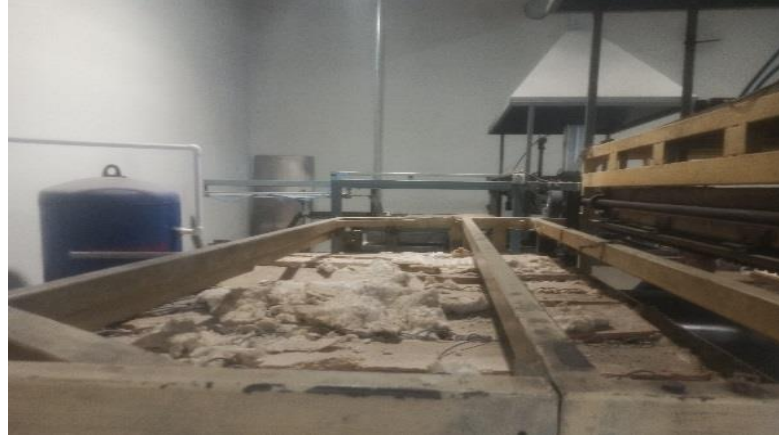
Şekil 3.20. Vakum makinelerindeki yalıtım probleminden görünüm
