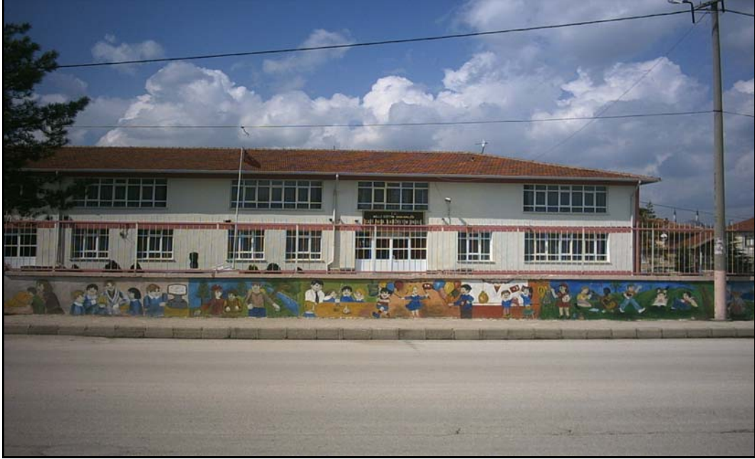
Şekil 4.32. Gazipaşa İlköğretim Okulu'ndan Bir Görünüm
