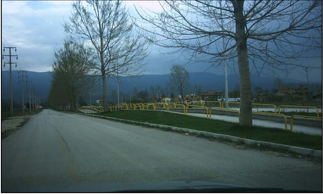
Şekil 4.38. Mahallelere Giren Yol Ayrımlarından Bir Görünüm
