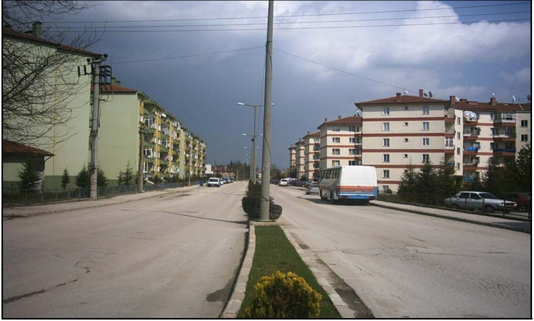
Şekil 4.30. Karaçayır Mahallesi'nin İçinden Geçen Cadde
