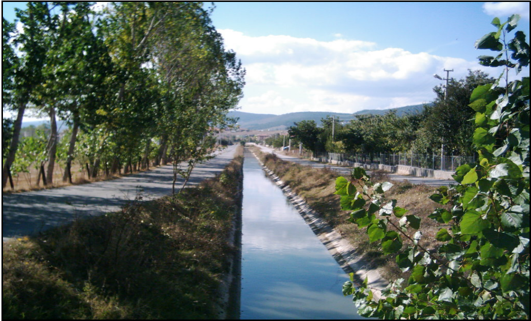
Şekil 4.26. Kanal Boyunca Devam Eden Yol Güzergahı
