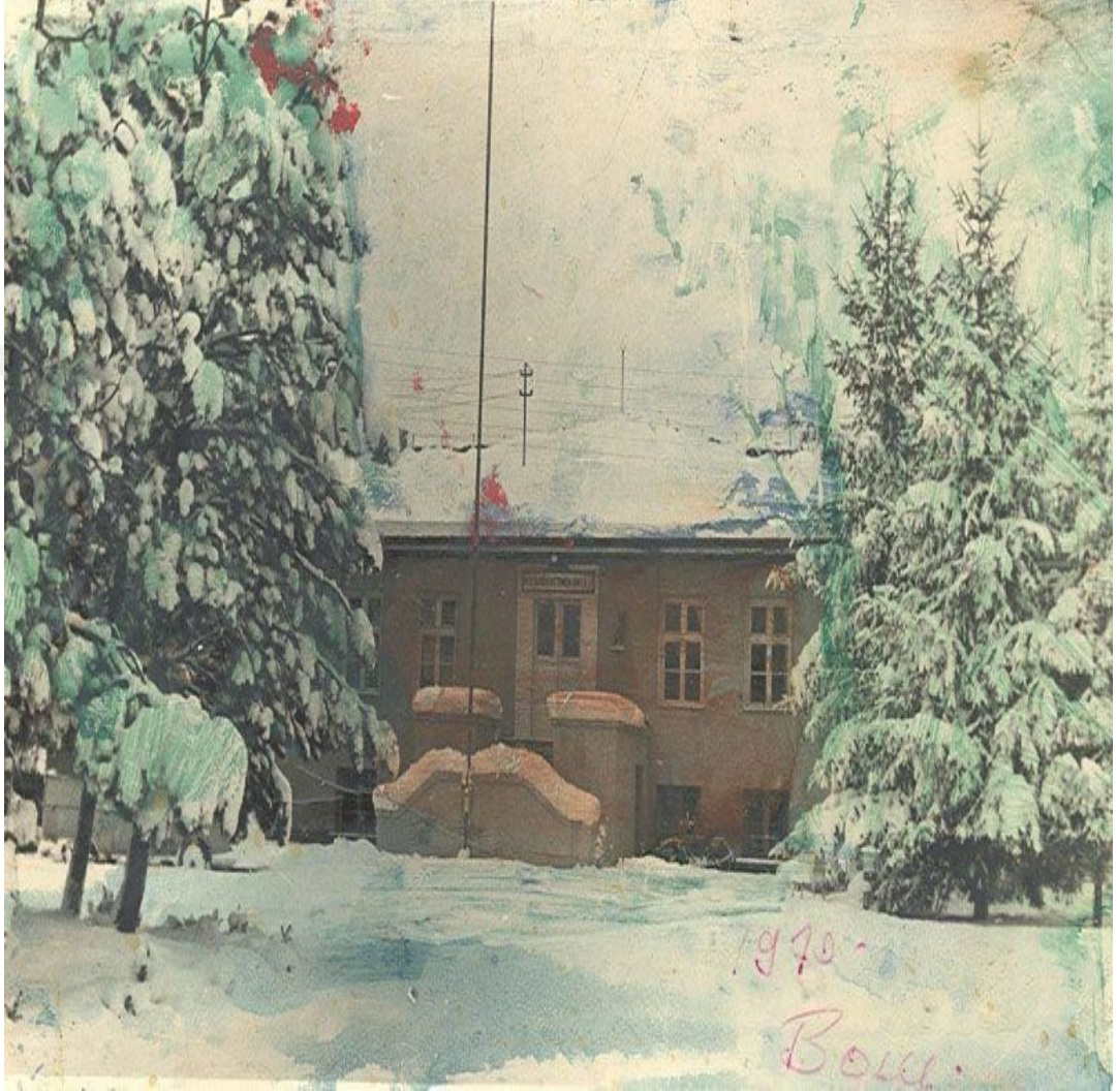
EK 6. Bolu Kız İlköğretmen Okulu Eski Bina Görünümü (Kadriye Dağ'ın Kendi Arşivinden)
