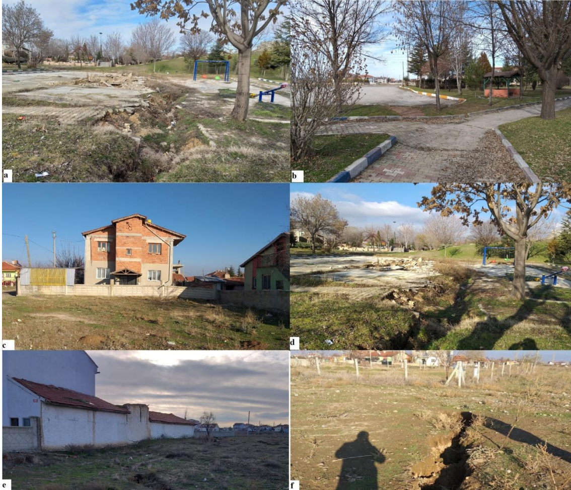
Şekil 4.2 Şehrin güney kısmında gözlenen yüzey deformasyonları. c-e-f) Kırkgöz Mahallesi'nde gözlenen yüzey kırıkları a-b-d) Akcan parkında gözlenen yüzey kırıkları.
