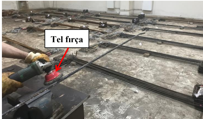
Şekil 5.3. Betonarme kolon boyuna ve sargı donatıları için mekanik temizleme işleri.
