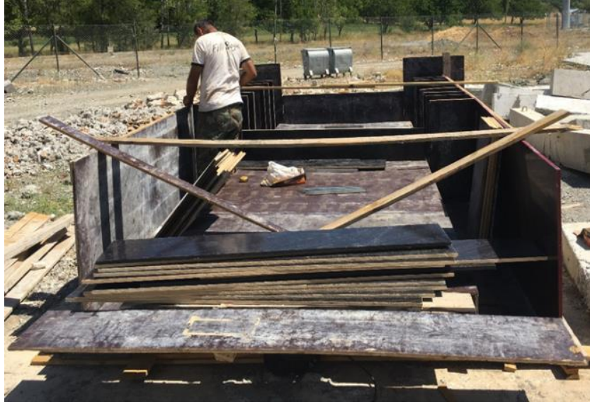
Şekil 4.24. Kolon numuneler için montajı yapılan betonarme kalıplar.
