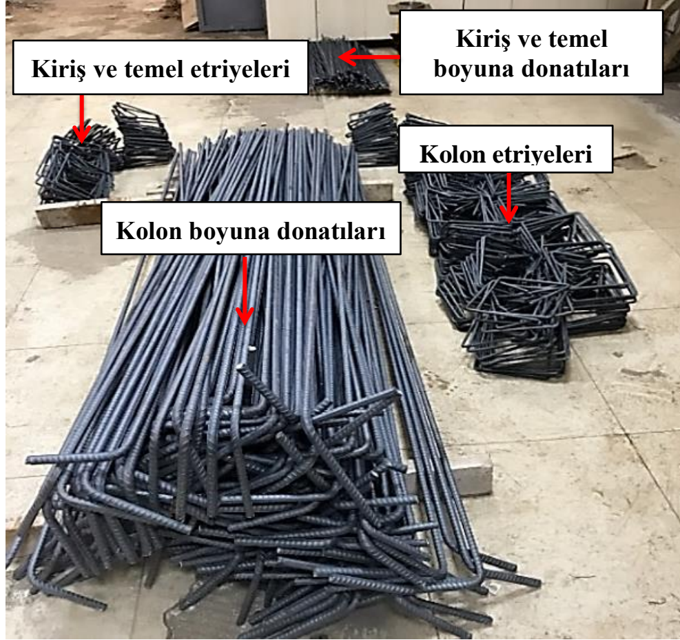
Şekil 4.8. Tasarım planına uygun olarak kesilmiş kolon, kiriş ve temel donatıları.
