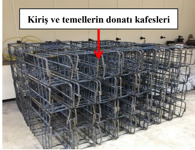
Şekil 4.19. Betonarme kiriş ve temel donatılarının bağlanması.
