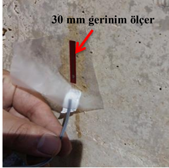
Şekil 4.46. Beton yüzey bölgesine gerinim ölçerin yapıştırılması.
