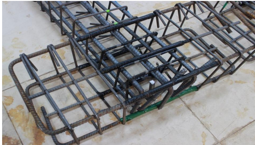
Şekil 4.16. Yalıtım işlemleri tamamlanmış betonarme donatılarının montajı.
