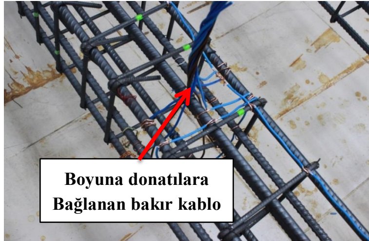
Şekil 4.21. Betonarme kolon boyuna donatılarına bakır kabloların bağlanması.
