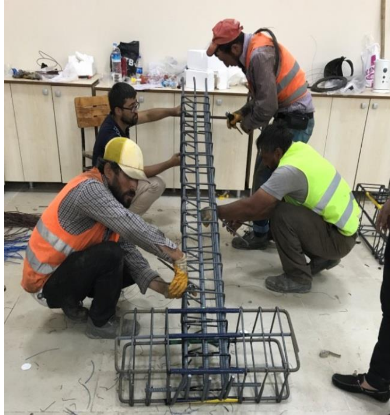
Şekil 4.20. Betonarme kolon boyuna ve sargı donatılarının bağlanması.
