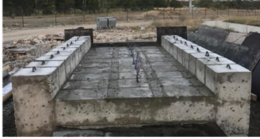
Őekil 4.29. Beton dkm sonrası kalıptan ıkarılan betonarme kolon numuneler.
