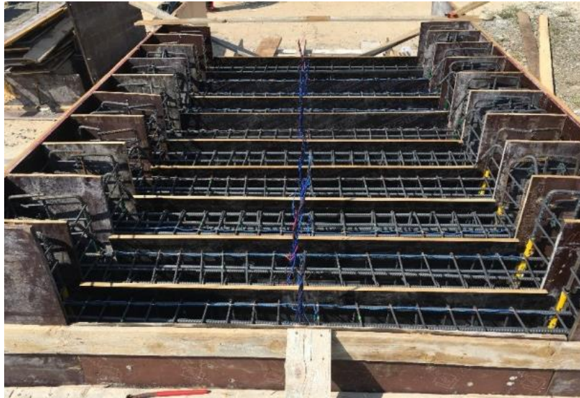
Şekil 4.25. Montajı tamamlanmış kalıplara donatı kafeslerin yerleştirilmesi.
