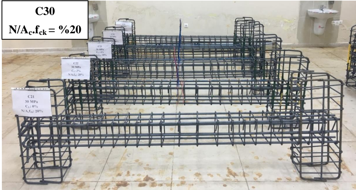
Şekil 4.23. Montajı tamamlanmış betonarme kolon numunelerinin donatı kafesleri.
