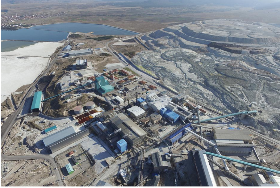
Şekil 2.2. Eskişehir Kırka bor işletme tesisi
