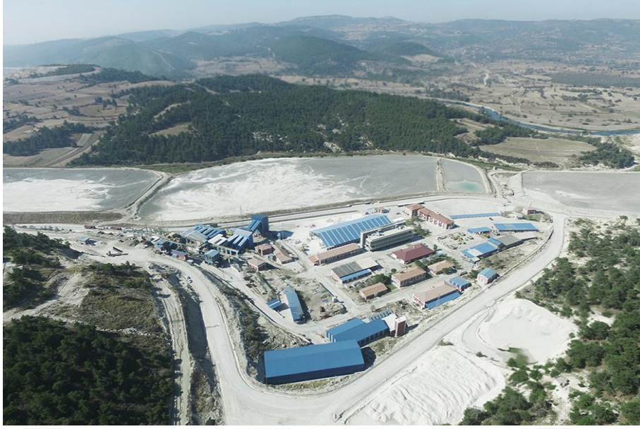
Şekil 2.4. Balıkesir Bigadiç bor işletme tesisi
