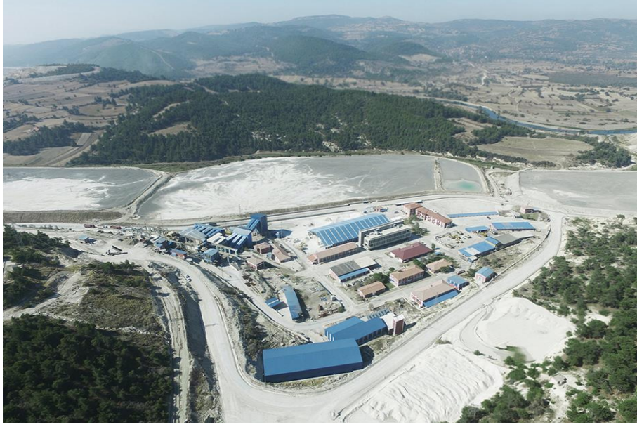
Şekil 2.4. Balıkesir Bigadiç bor işletme tesisi
