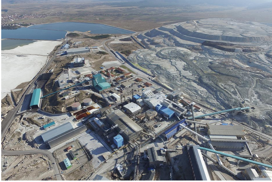
Şekil 2.2. Eskişehir Kırka bor işletme tesisi
