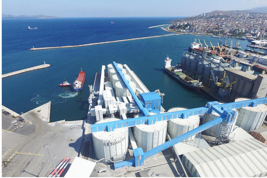
Şekil 2.5. Balıkesir Bandırma bor işletme tesisi
