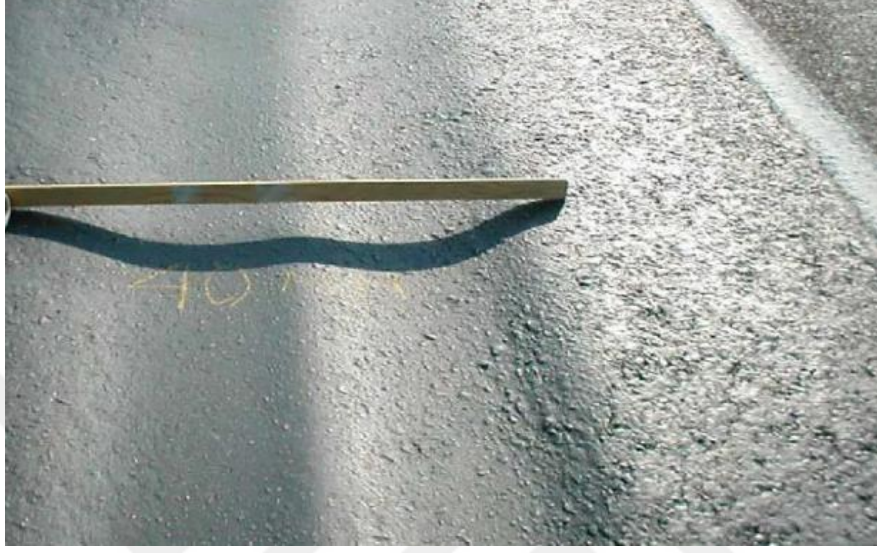
Şekil 21. Tekerlek izi deformasyonu (URL-8, 2023)(URL-7, 2023)
