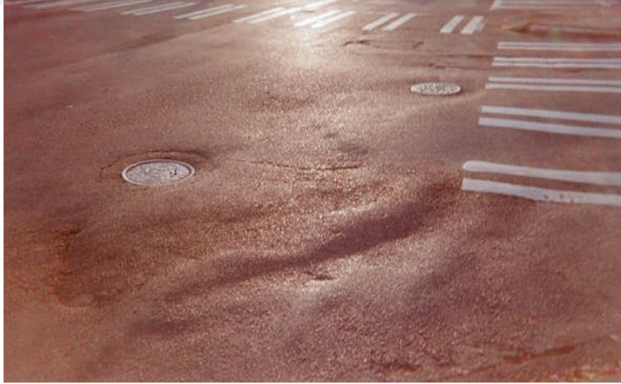
Şekil 23. Kaplamada meydana gelen ondülasyonlar (URL-9, 2023)
