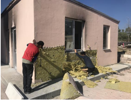
a. Taş yünü malzemesinin sökülmesi
