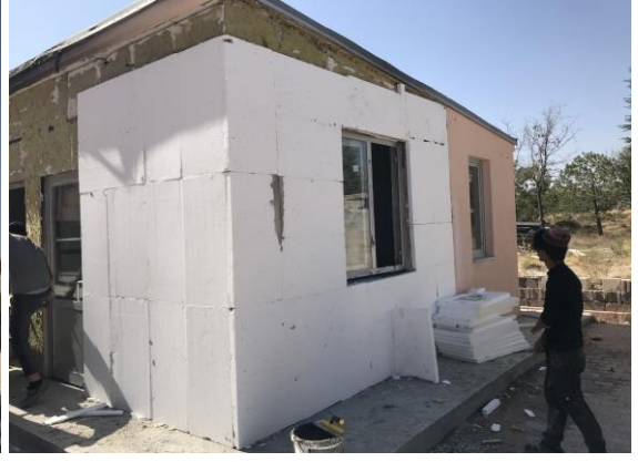
d. EPS yalıtım malzeme uygulaması
