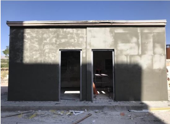
1. İlk kat sıva bitirilme görüntüsü
