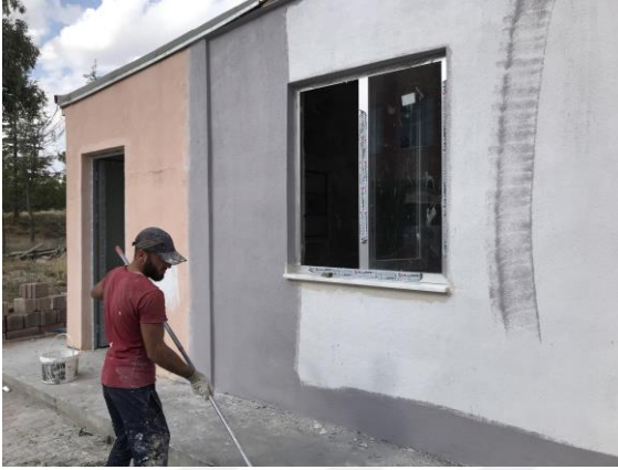
l. Son kat boya uygulaması
